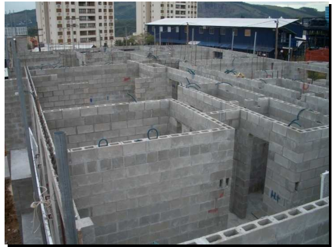
Figura 18 – Sistema elétrico, obra limpa
