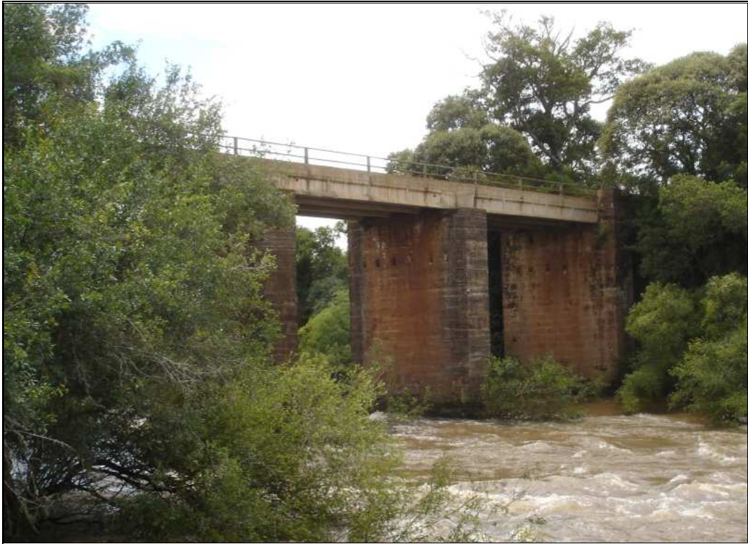
Figura 19: Ponte sobre o rio Ijuizinho (Fonte: O autor 2011).
