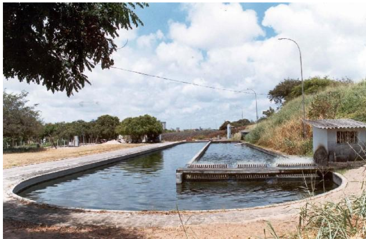
Figura 31: Vista do valo de oxidação da ETE – UFRN Fonte: Bezerra (2005)
