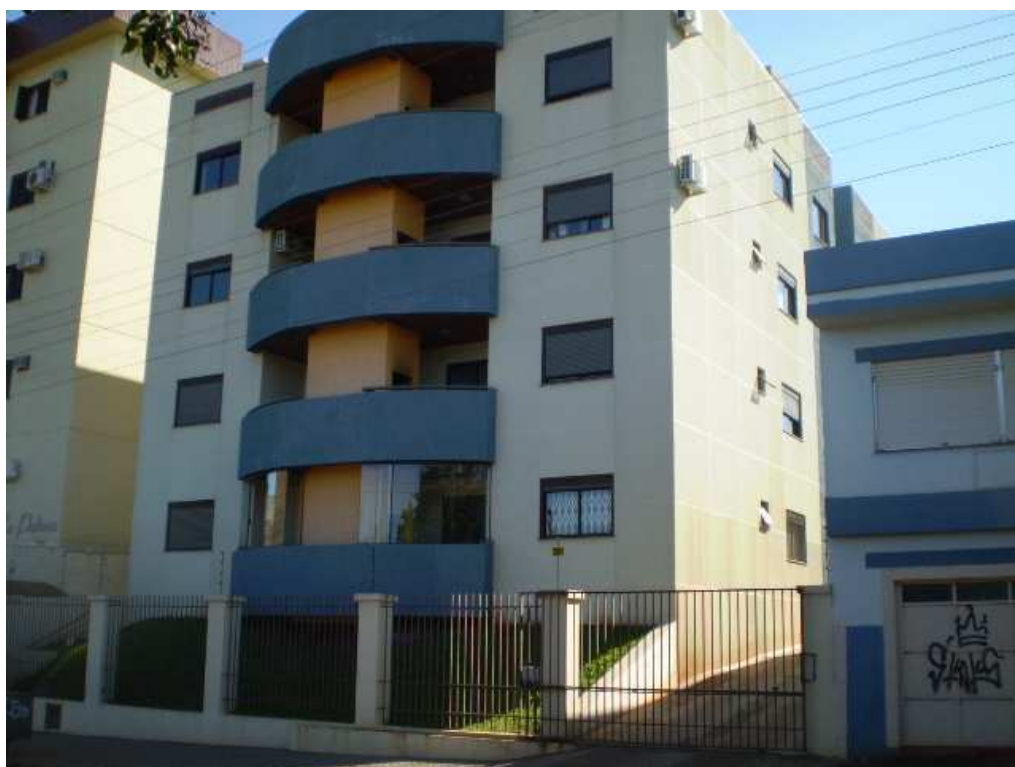
Figura. 15: Vista externa do Residencial Monet
