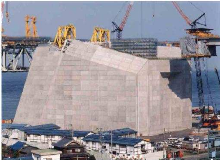
Figura 3: Ancoragem da ponte Akashi-Kaikyo
