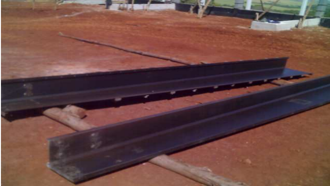
Figura 15: fôrma metálica utilizada na execução in-loco .
