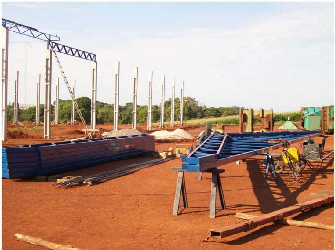
Figura 7 – Preparo para montagem da estrutura.
