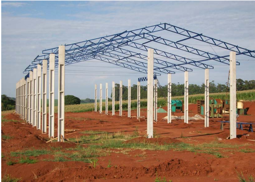
Figura 5 – Sistema estrutural em “esqueleto”.
