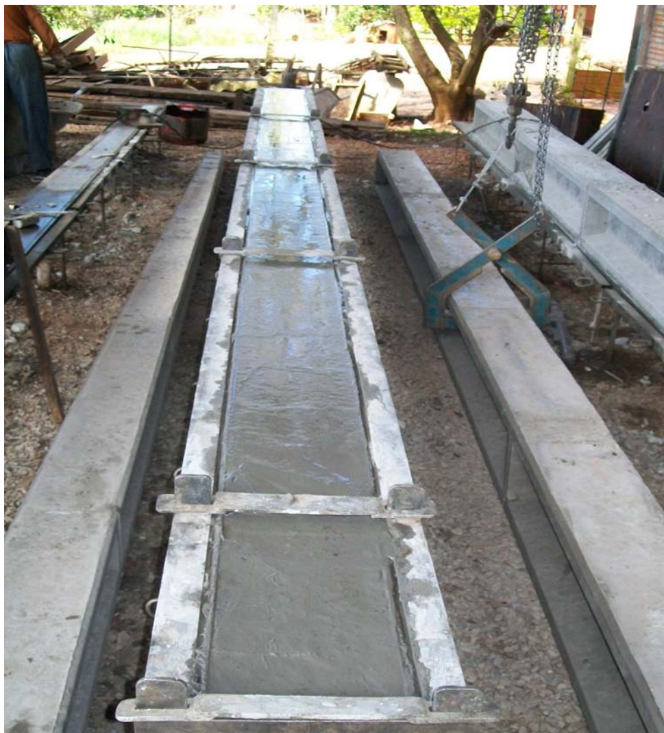
Figura12 – Fôrma com pilar pré-moldado, concretado.
