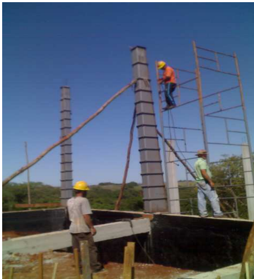
Figura 16: fôrma metálica sendo preparada para execução in-loco .
