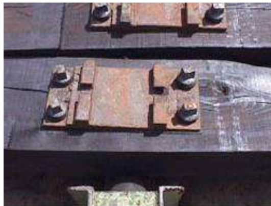
Figura 22: Placa de apoio Fonte: PORTO, 2004
