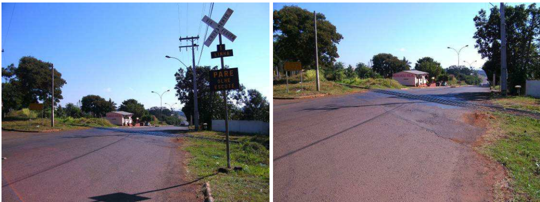
Figura 46: Vistas parciais do Site A Fonte: Autoria própria, 2009
