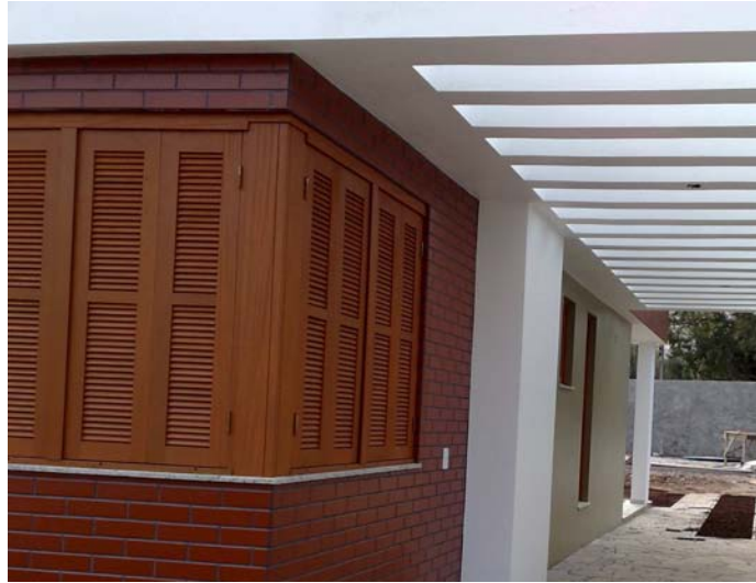
Figura 37: Esquadria de madeira da Edificação Unifamiliar.
