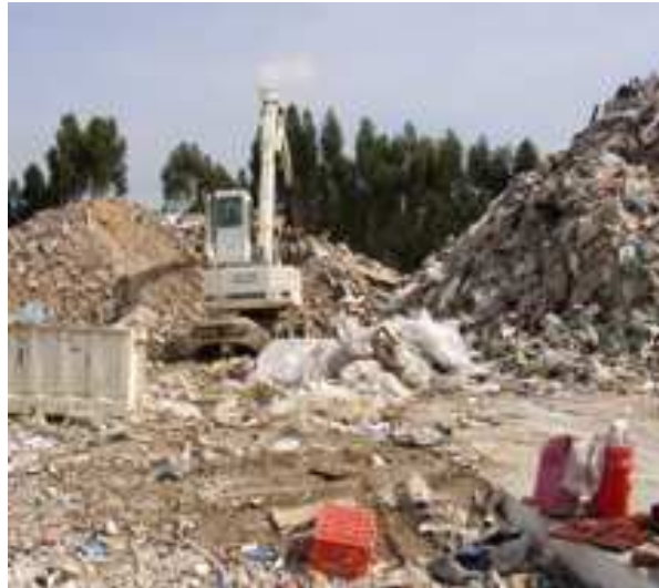
Figura 31: Depósito de Resíduos da Construção Civil.
