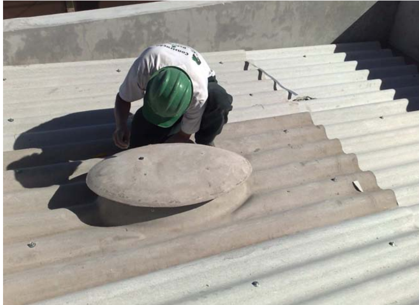
Figura 40: Telhado de Fibrocimento
