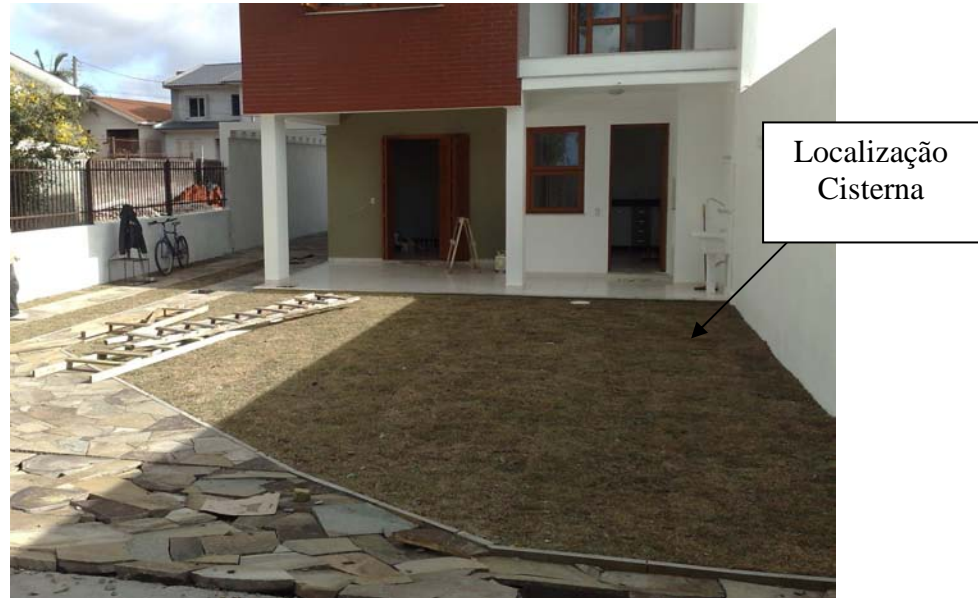
Figura 43: Vista parcial do terreno e localização da cisterna.
