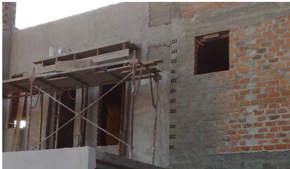
Figura 39: Parede Tijolo Furado Fachada oeste
