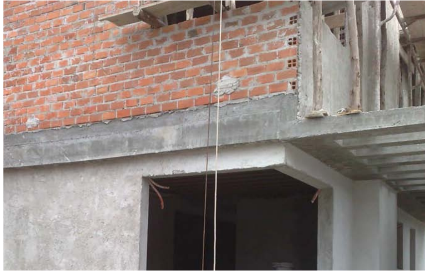
Figura 38: Parede Tijolo Furado Fachada
