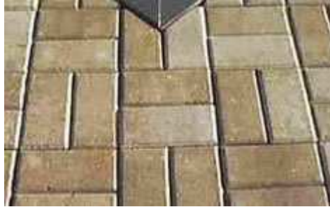
Figura 20: Assentamento Trama
