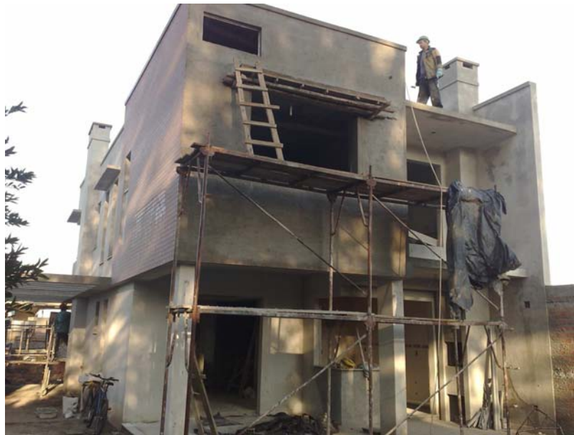
Figura 36: Foto da obra em etapa construtiva.
