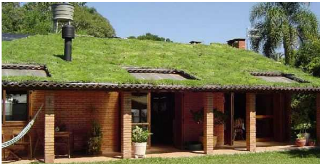
Figura 16: Aplicação da ecotelha na cobertura de uma Residência.
