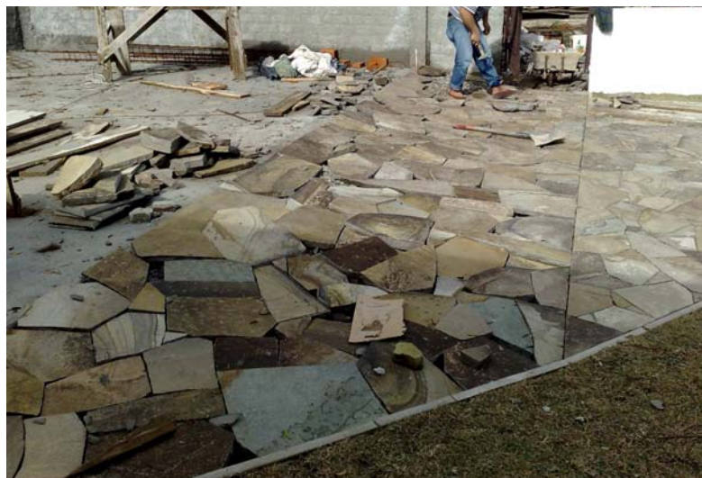
Figura 41: Pavimentação Externa com Pedras Naturais
