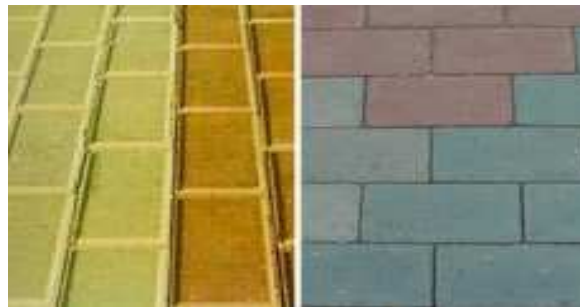
Figura 21: Assentamento Fileira ou Corredor
