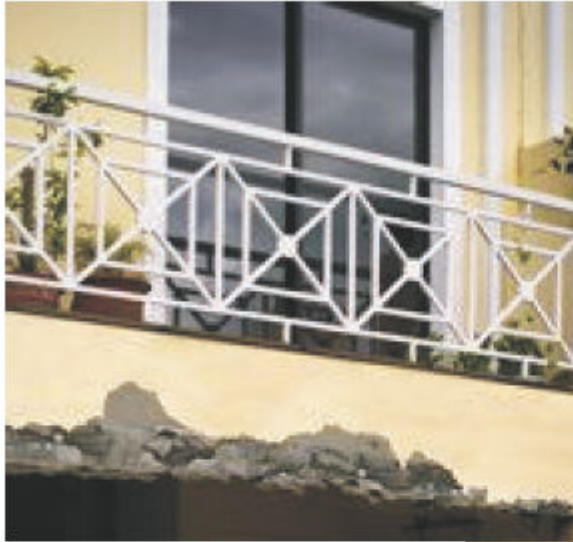
Figura 30: Baixo cobrimento de concreto. Fonte: Arquivo pessoal, 2009.
