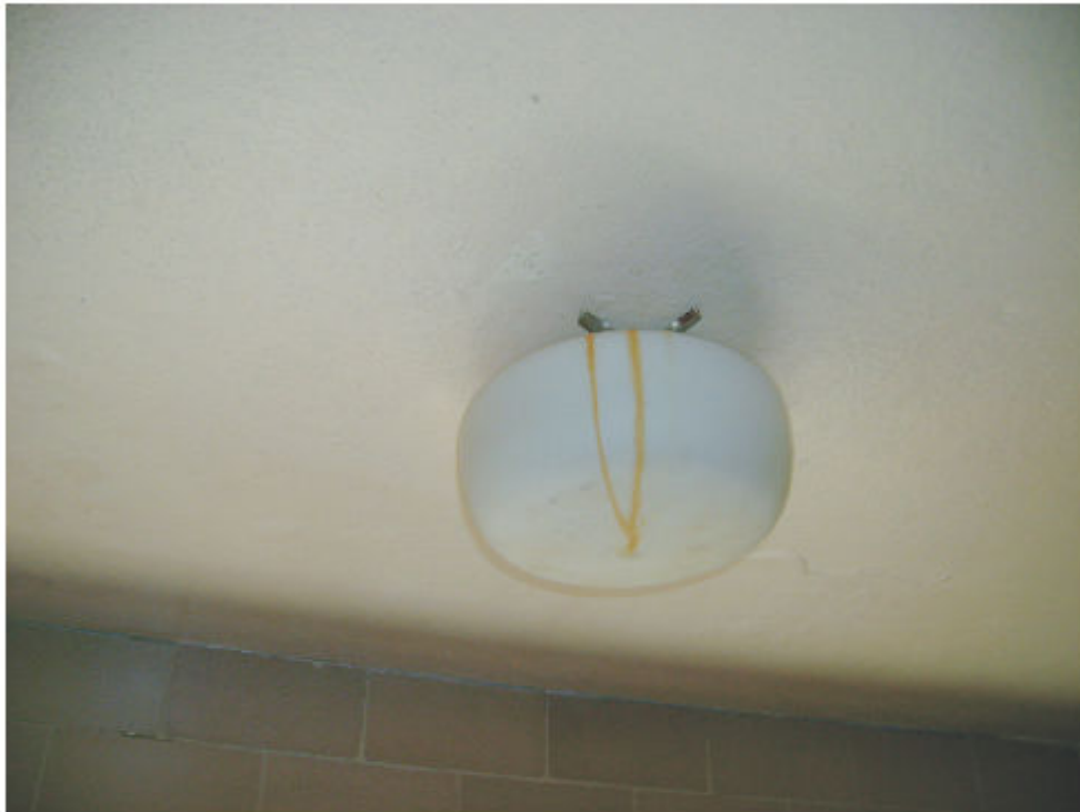
Figura 25: Goteira pela lâmpada. Fonte: Arquivo pessoal, 2009.
