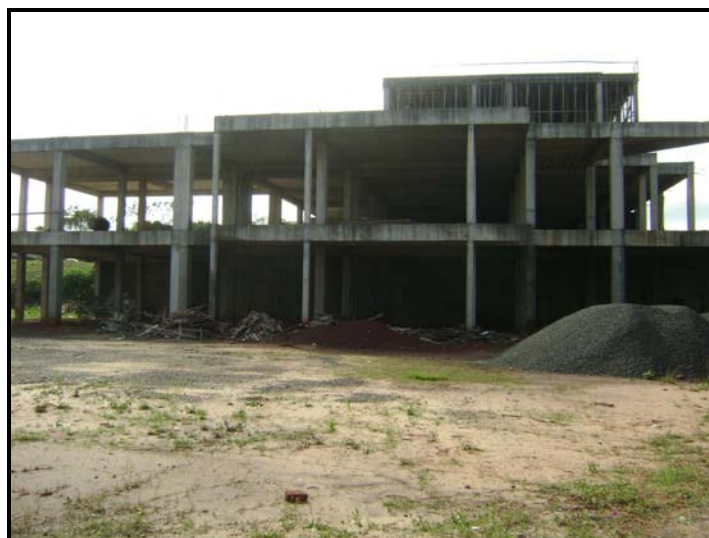
Figura 9: Vista dos fundos de parte da obra – 07/out/2009. Fonte: Autoria própria, 2009.
