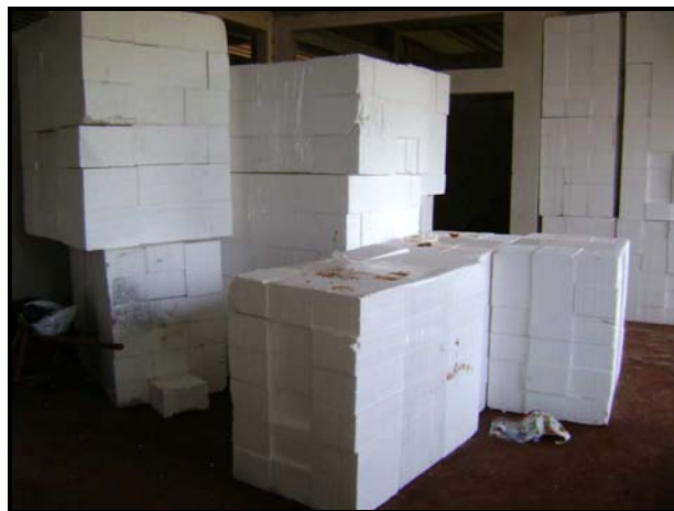
Figura 27: Estocagem de bloco de EPS no canteiro – jun/2009. Fonte: Autoria própria, 2009.
