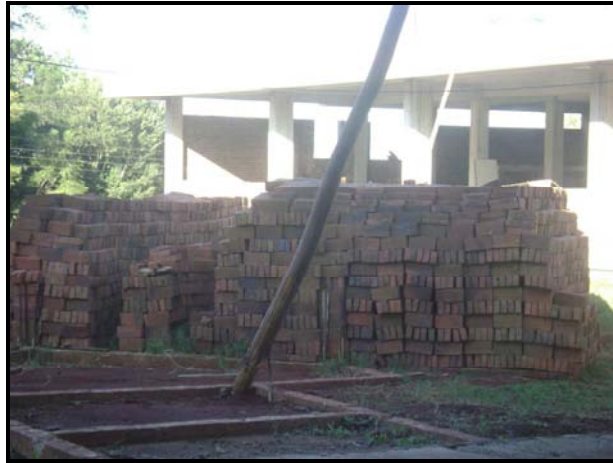
Figura 24: Local de armazenamento de tijolos – mai/2009. Fonte: Autoria própria, 2009.
