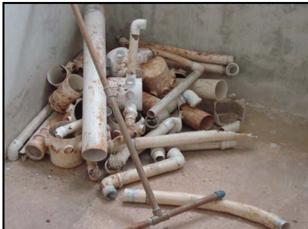
Figura 39: Geração do entulho das instalações de esgoto – out/2009. Fonte: Autoria própria, 2009.
