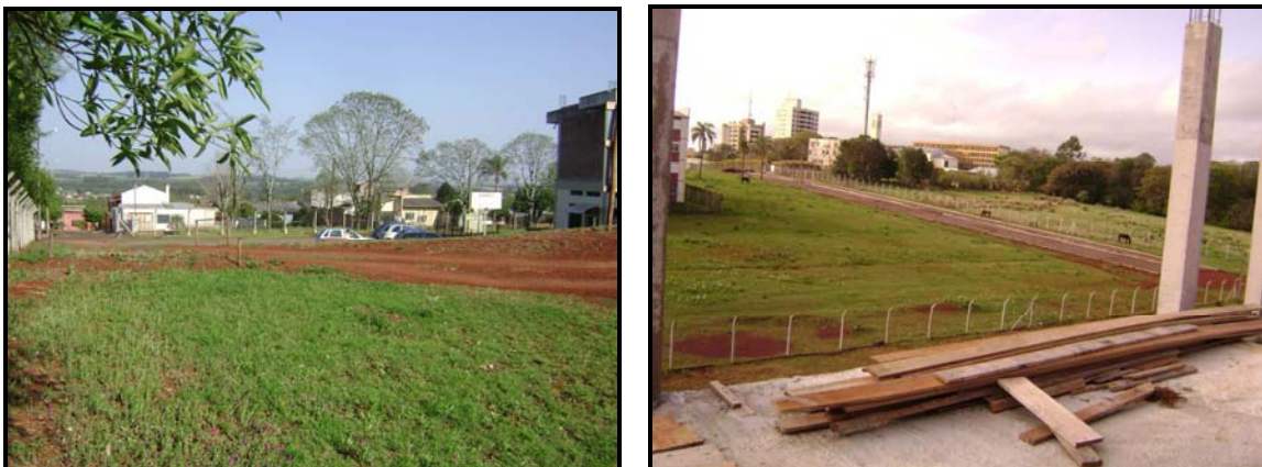
Figura 13: Acesso atual à obra e futuro acesso em fase de conclusão – out/2009. Fonte: Autoria própria, 2009.
