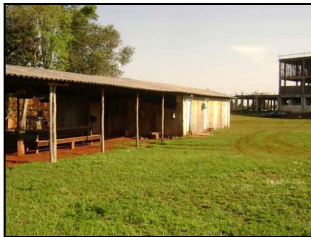
Figura 12: Instalações Provisórias do canteiro de obras – set/2009. Fonte: Autoria própria, 2009.
