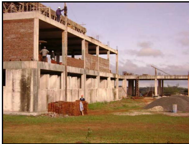
Figura 35: Funcionamento do guincho para transporte vertical – set/2009. Fonte: Autoria própria, 2009.
