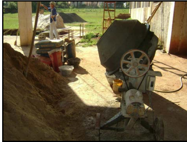
Figura 28: Local onde ocorre a produção de argamassa/concreto – out/2009. Fonte: Autoria própria, 2009.
