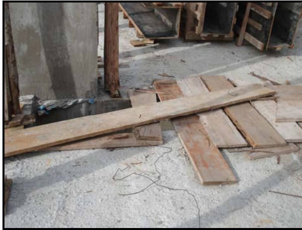
Figura 22: Proteção com tábuas em aberturas no piso – mai/2009. Fonte: Autoria própria, 2009.
