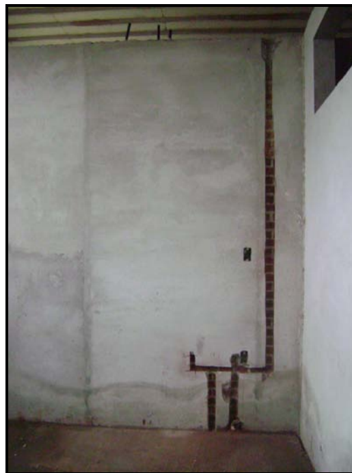
Figura 37: Quebra na alvenaria para embutir instalações – set/2009. Fonte: Autoria própria, 2009.
