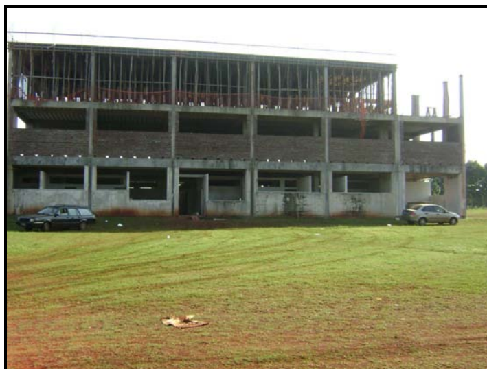
Figura 8: Vista frontal de parte da obra – 04/out/2009. Fonte: Autoria própria, 2009.
