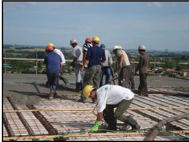
Figura 19: Imagem da concretagem da laje, visualizando a utilização de EPI's – out/2009. Fonte: Autoria própria, 2009.
