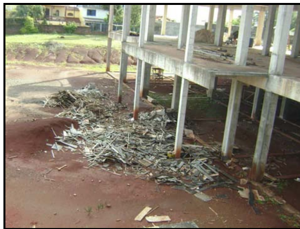
Figura 23: Local de armazenagem do entulho de madeira gerado na obra – jul/2009. Fonte: Autoria própria, 2009.
