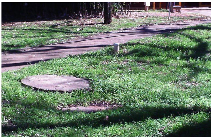
Figura 10: Fossa séptica seguido de um sumidouro.
