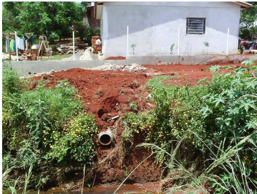
Figura 01: Esgoto descartado no meio ambiente na cidade Ijuí/RS.
