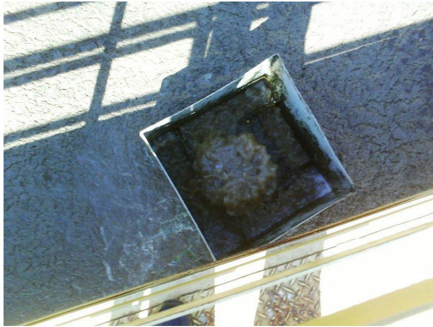
Figura 27: Lodo gerado sendo separado do efluente tratado.
