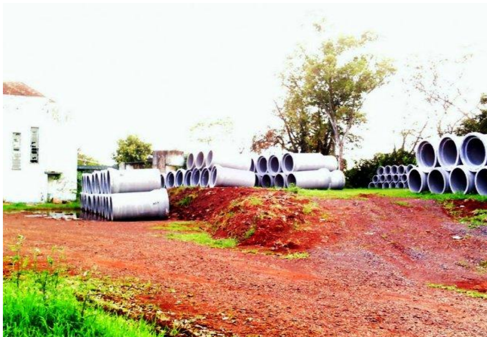
Figura 03: Tubos para obra do interceptor no terreno da Corsan-Ijuí/RS.
