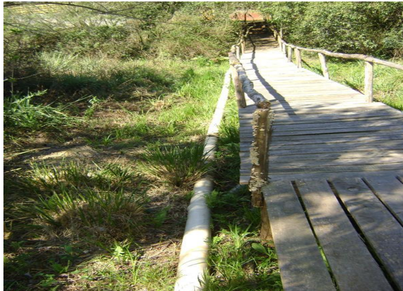
Figura 31 (b): Tubulação de PVC.
