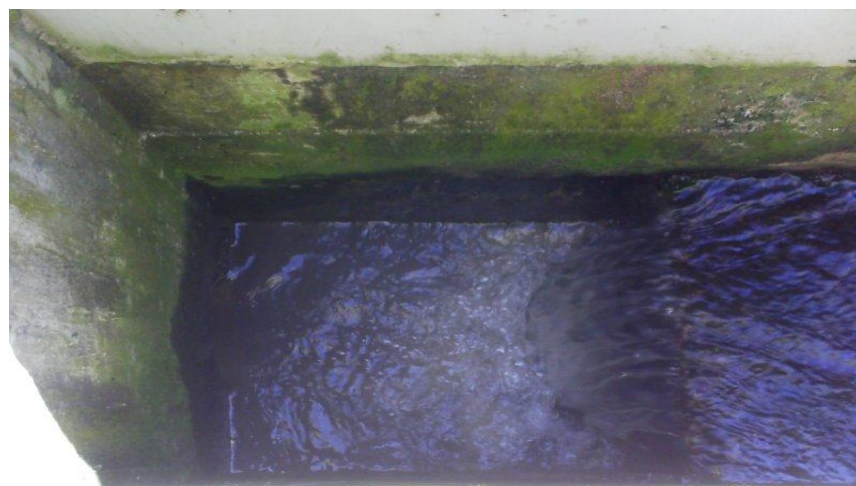
Figura 30: Vazão de saída do efluente tratado da ETE.
