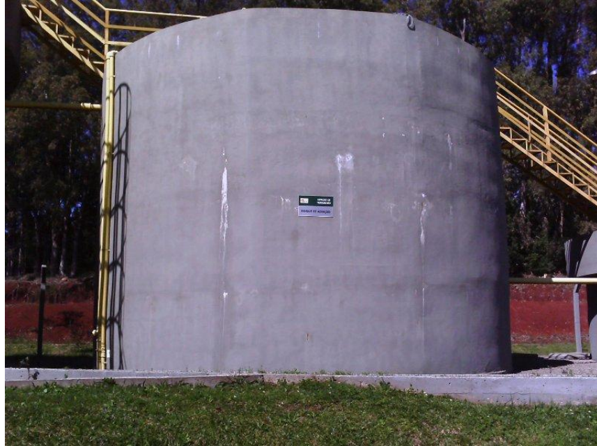
Figura 24: Tanque de Aeração.
