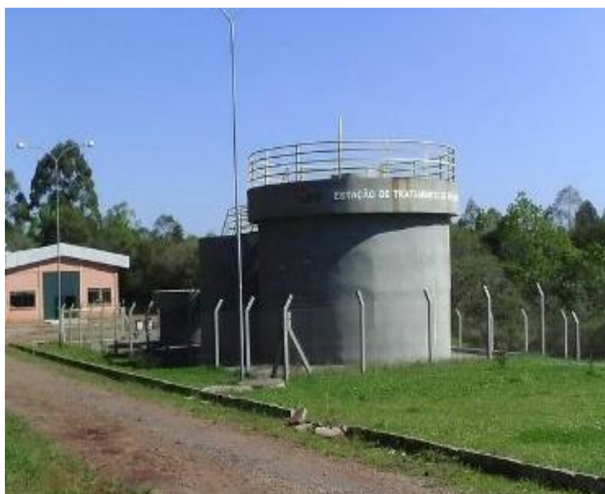
Figura 14: Vista do terreno onde está localizada a ETE da UPF.
