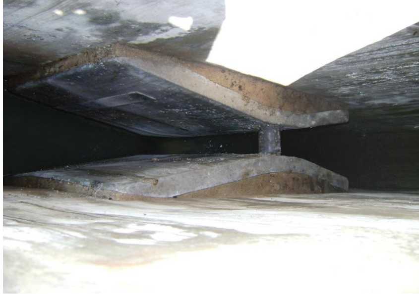
Figura 20: Controlador de Fluxo, (Calha Parshall).
