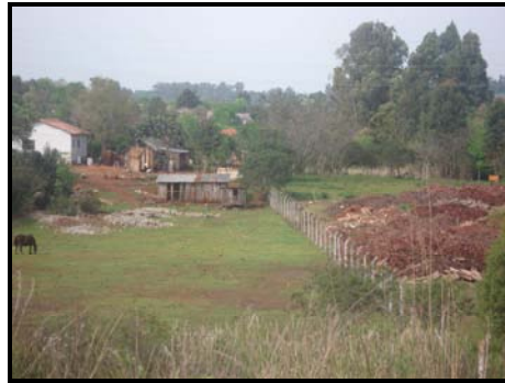
Figura 36: Área de deposição irregular de RCD no Bairro: Pindorama, ao lado da Pedreira
