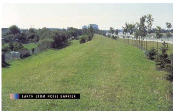
Figura 07: Talude como barreira sonora.
