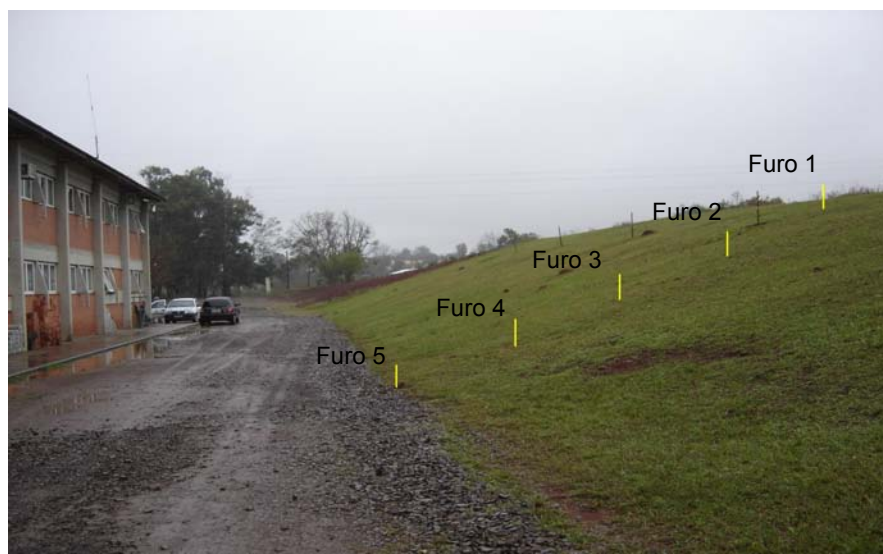
Figura 25: Locais ensaiados no talude do campus
