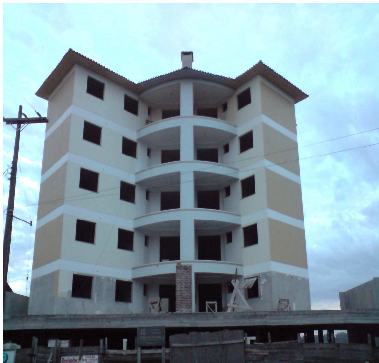
Figura 1 – Fachada Principal da Edificação Analisada
