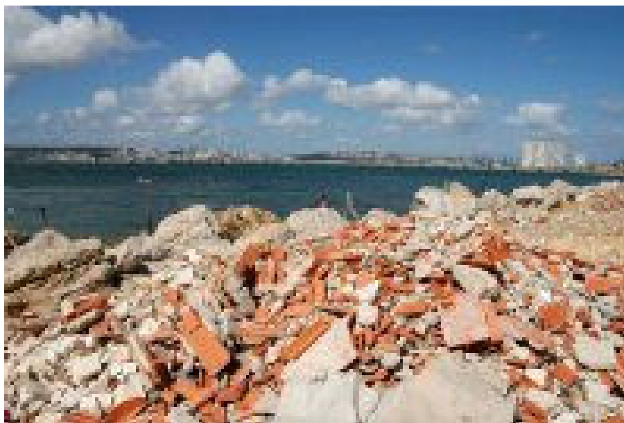
Figura 16: Depósito de RCD.
