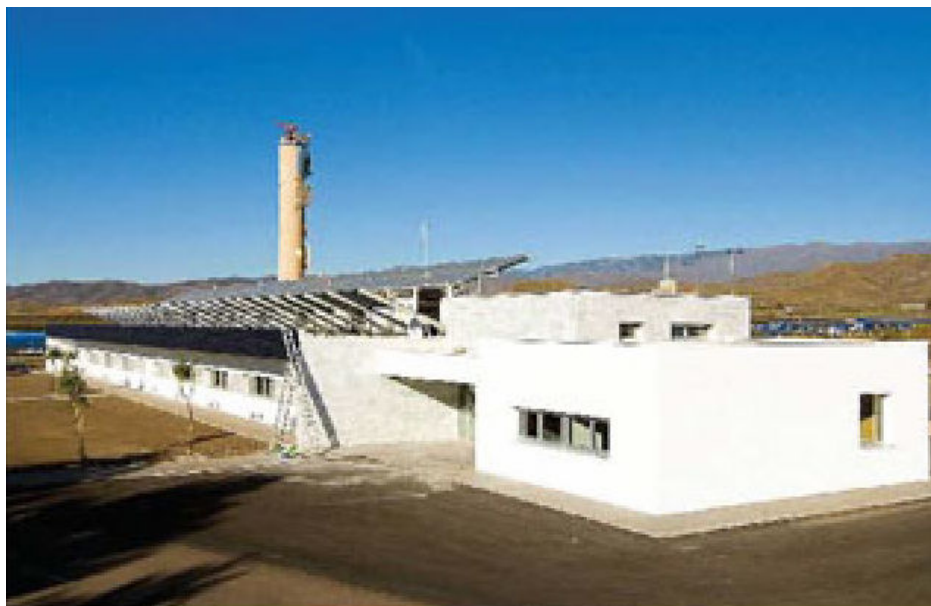
Figura 17: Painéis fotovoltaicos e coletores de água.
