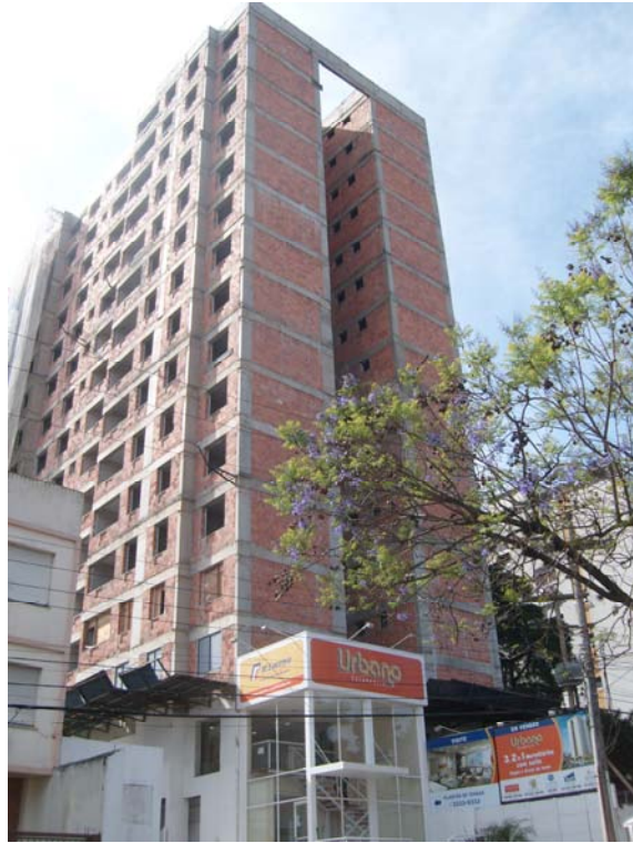
Figura 32: Situação atual da obra.
