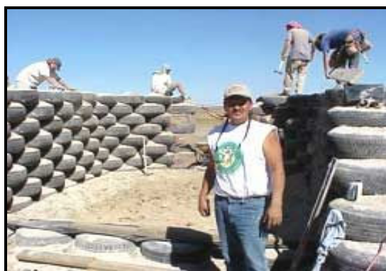
Figura 27: Casa construída com pneus descartados na natureza
