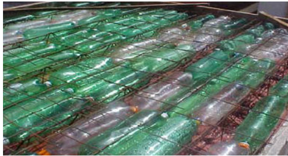
Figura 21: Malha para evitar fissuração por retração.
