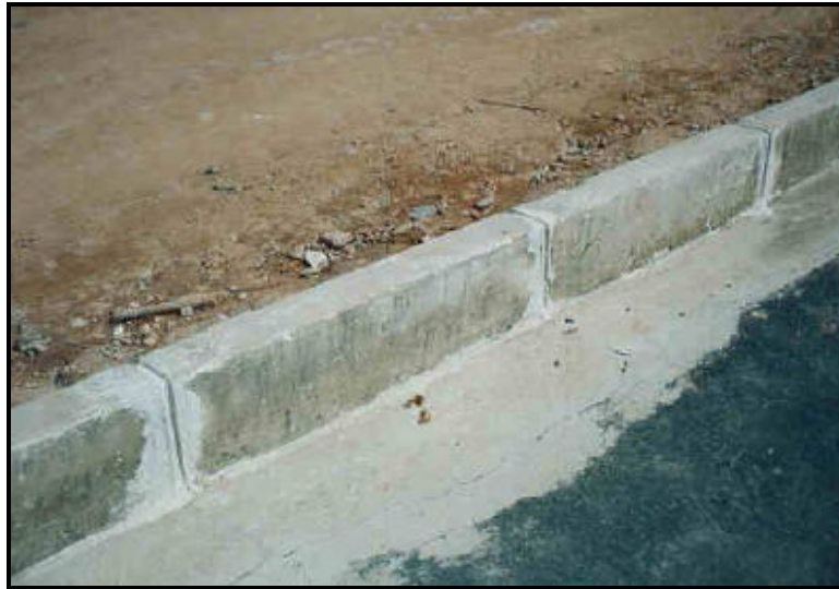
Figura 10: Aplicação de RCD em meio-fios
