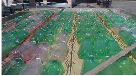
Figura 24: Colocação das garrafas entre as nervuras.
