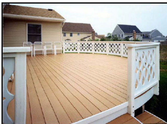
Figuras 22a e 20b: Construção de píeres ou deques com elementos de plástico reciclado da empresa Plastic Lumber Yard (EUA).
