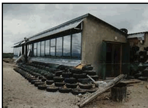
Figura 29: Casa pronta feita inteiramente com pneus.
