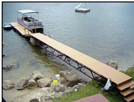
Figuras 22a e 20b: Construção de píeres ou deques com elementos de plástico reciclado da empresa Plastic Lumber Yard (EUA).
