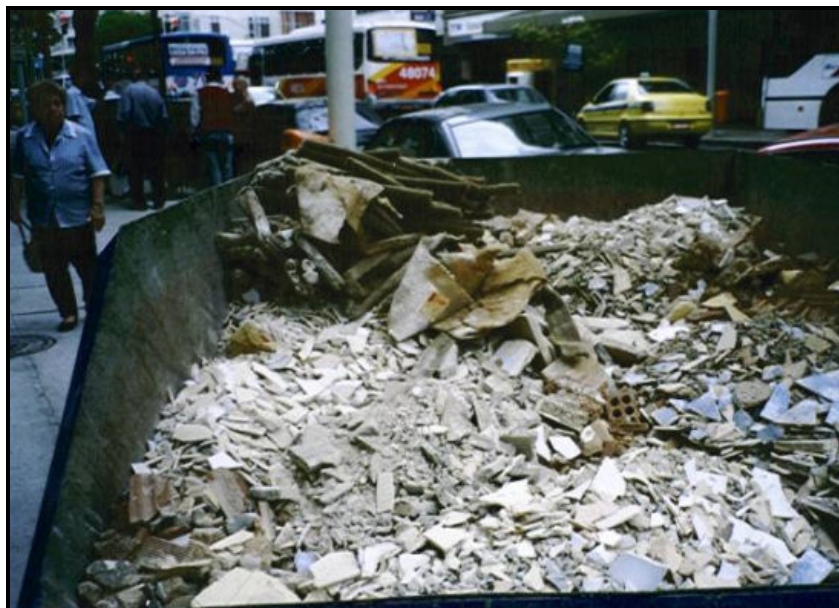
Figura 4: Disposição de resíduos não inertes em caçambas coletora de RCD.
