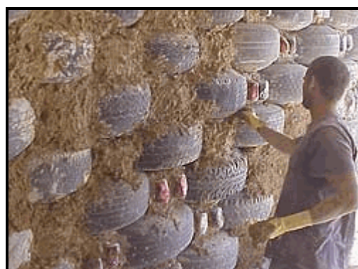
Figura 28: Paredes com feitas com pneus
