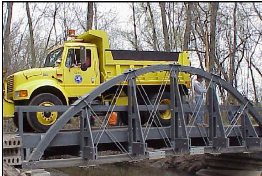
Figura 19: Ponte sobre o rio Hudson com plástico reforçado com fibra de vidro.
