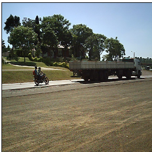
Figura 14: Vista do ponto 3, sentido leste-oeste.
