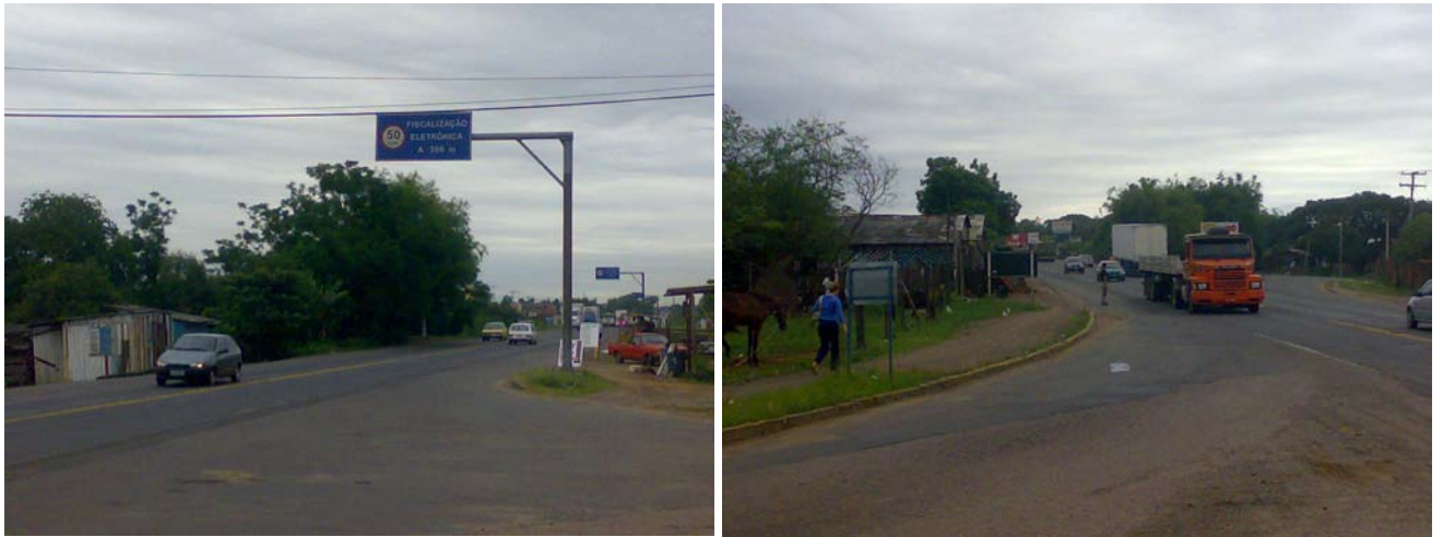
Figura 30 e 31 : Vista geral do Ponto 3
