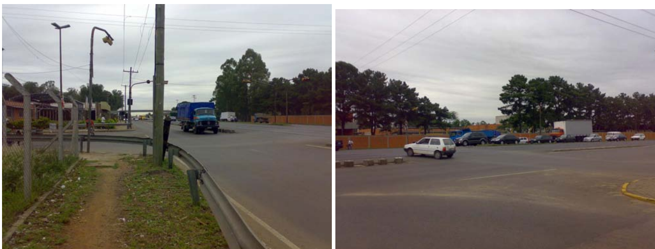
Figura 26 e 27 : Vista geral do Ponto 1
