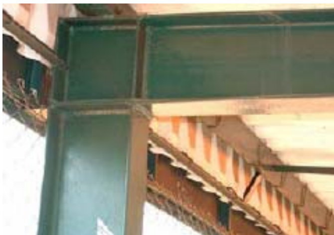
Figura 6 – Ligação soldada (viga / pilar) Fonte: CBCA (2007)
