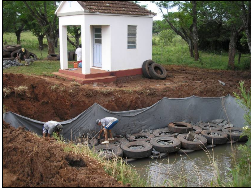
Figura 37: Muro em execução
