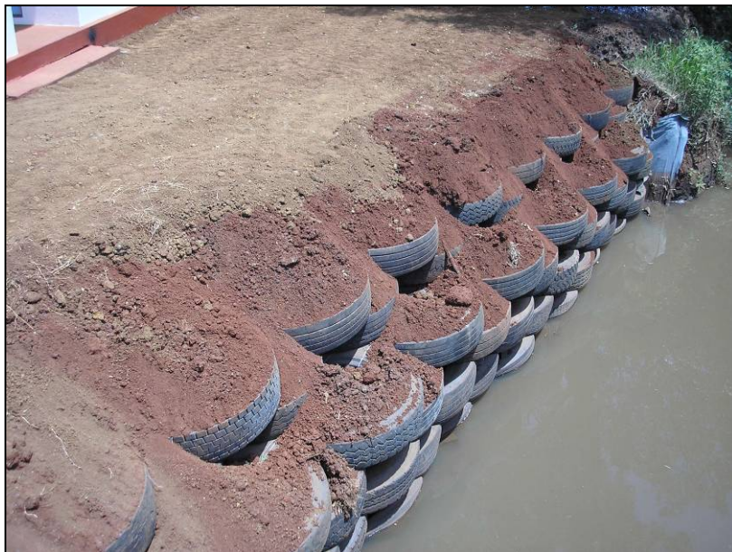
Figura 40: Estrutura após retro-aterro, novembro 2005
