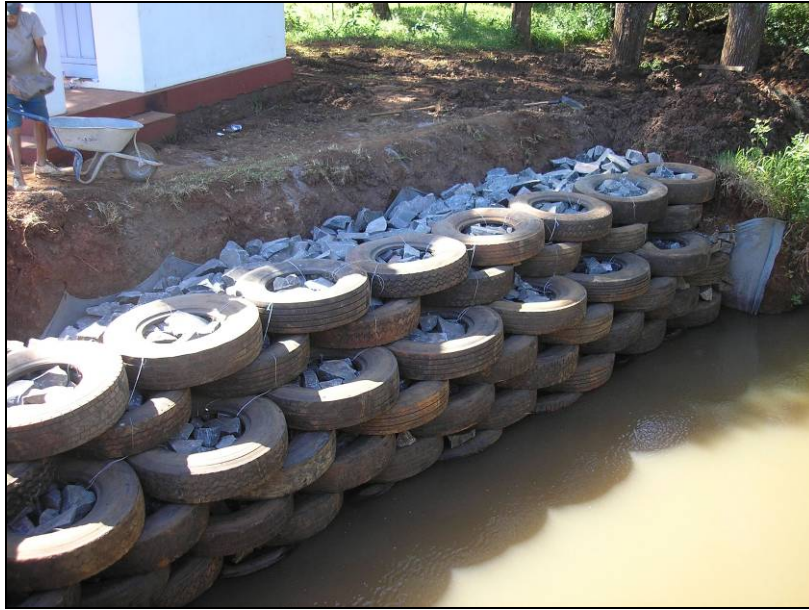
Figura 39: Estrutura de pneus executada
