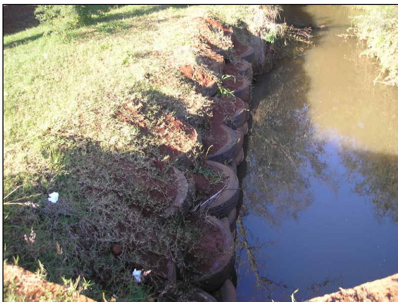
Figura 41: Estrutura em março de 2007
