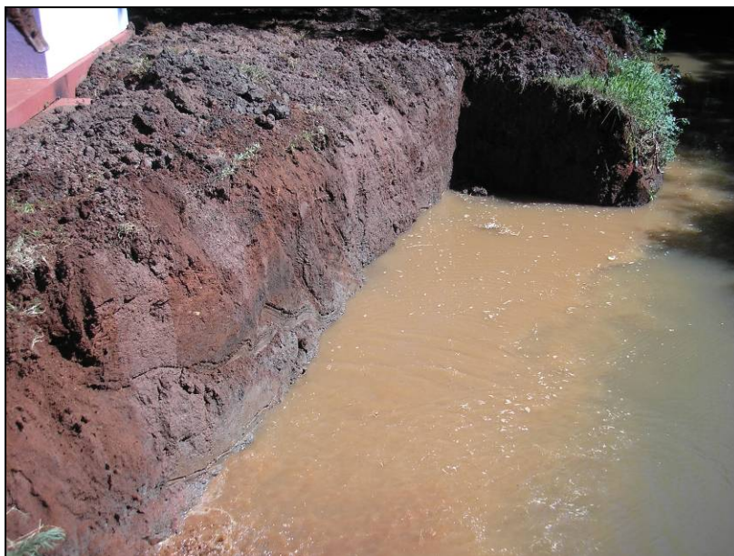
Figura 36: Abertura de vala
