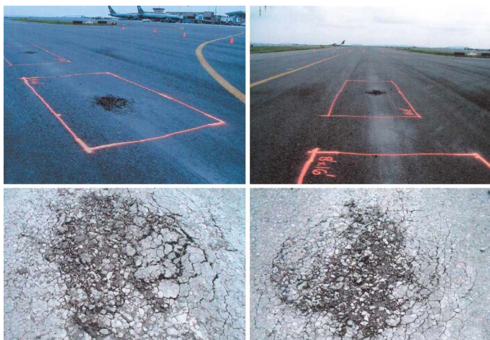
Figura 8: Efeito deletério da água
