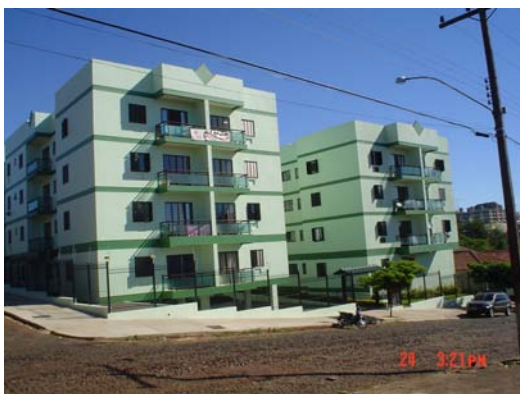
3- Apto (edificação com 4 pavimentos, sem elevador)
