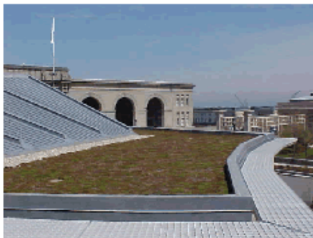
Figura 12: Aplicação da ecotelha na cobertura de uma edificação. Fonte: www.ecotelhado.com.br
