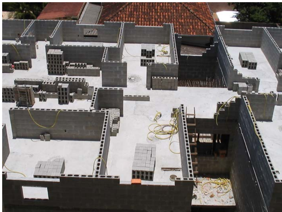
Figura 11: Vista parcial das alvenarias do pavimento tipo
