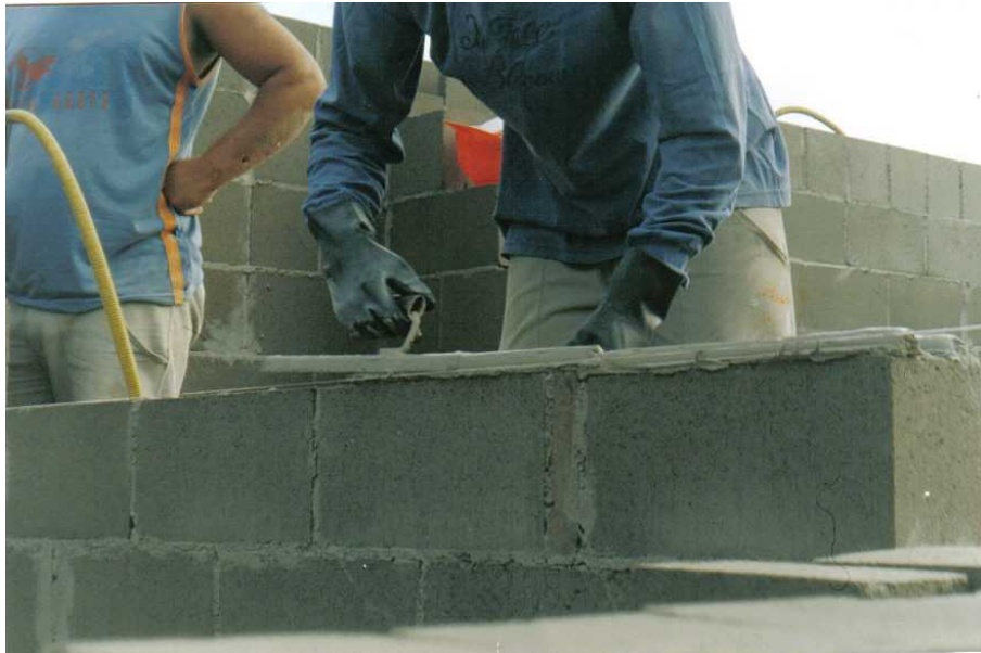
Figura 15: Assentamento dos blocos de concreto
