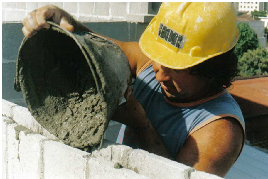
Figura 17: Concretagem dos blocos “U” da fiada de respaldo
