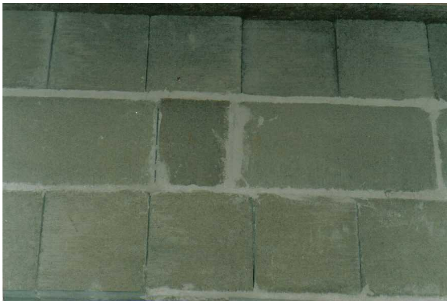
Figura 13: Detalhe do assentamento dos blocos “U”
