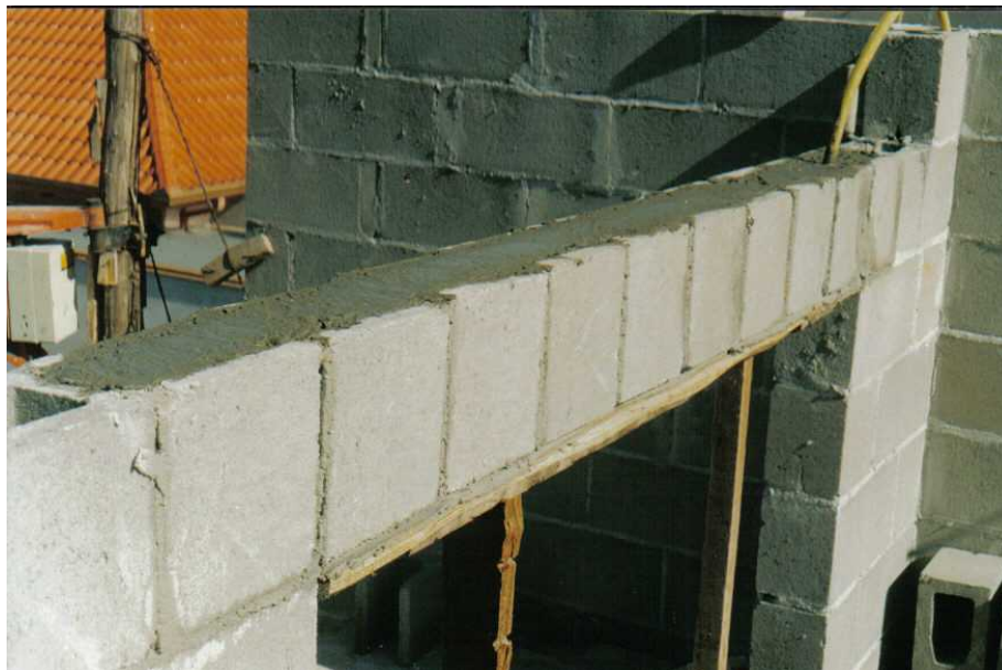
Figura 14: Detalhe da verga da porta da sacada
