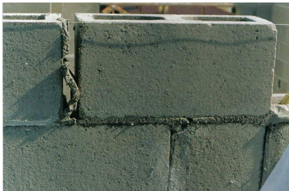
Figura 21: Erro de modulação da fiada
