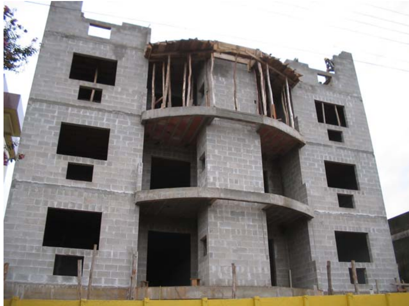
Figura 10: Vista parcial da fachada principal
