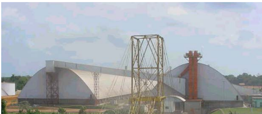
Figura 1: Unidade de armazenagem do tipo armazém graneleiro Fonte: Kepler Weber Industrial S.A. (2002)
