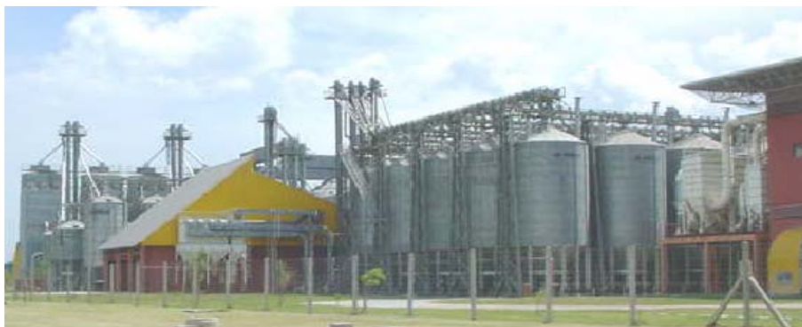
Figura 4: Unidade de armazenagem do tipo silos metálicos Fonte: Kepler Weber Industrial S.A. (2002)
