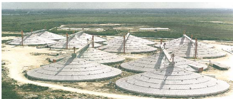
Figura 5: Unidade de armazenagem do tipo silos metálicos Fonte: Kepler Weber Industrial S.A. (2002)
