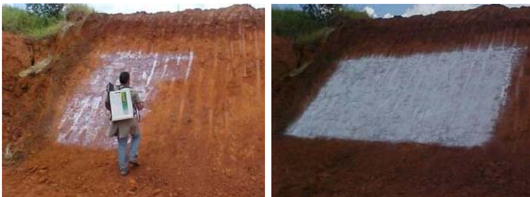
Figura 17: Aplicação de calda fluída de cal com aglutinantes fixadores.
