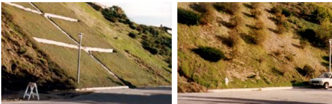
Figura 16: Revestimento do talude com espécies vegetais.
