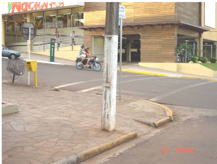
Figura 28 – Sinalização de pedestre deficiente na Rua Ernesto Alves
