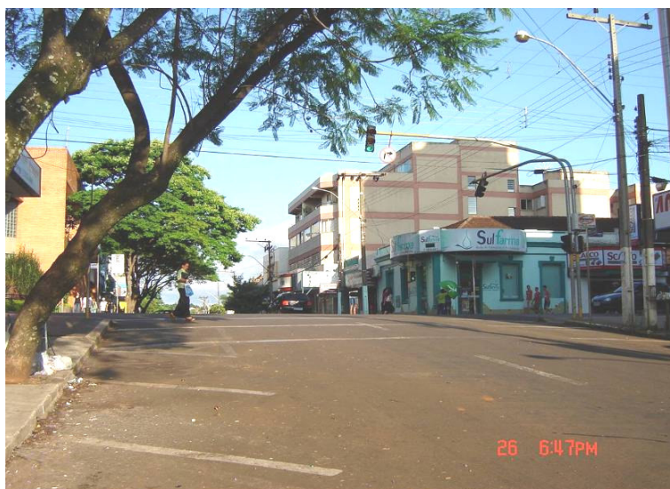
Figura 33 – Local de acidente de trânsito com danos materiais na Rua 15 de Novembro com Rua Ernesto Alves
