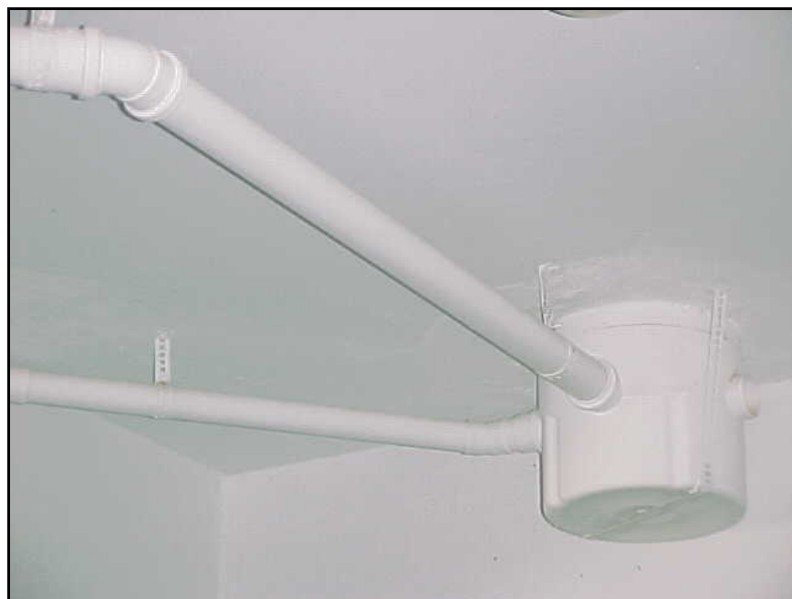
Figura 23: Vista do tubo de PVC para esgoto no Edifício São Paulo no subsolo
