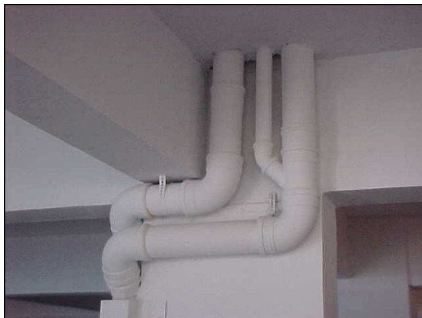
Figura 25: Vista do tubo de PVC para esgoto no Edifício São Paulo no subsolo
