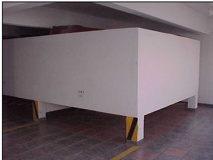
Figura 18: Vista do reservatório inferior no Edifício São Paulo
