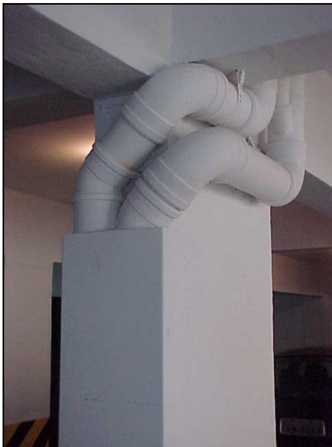
Figura 22: Vista do tubo de PVC para esgoto no Edifício São Paulo no subsolo
