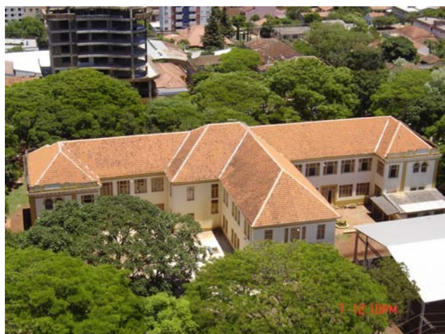
Figura 12 – Vista da parte de trás da edificação
