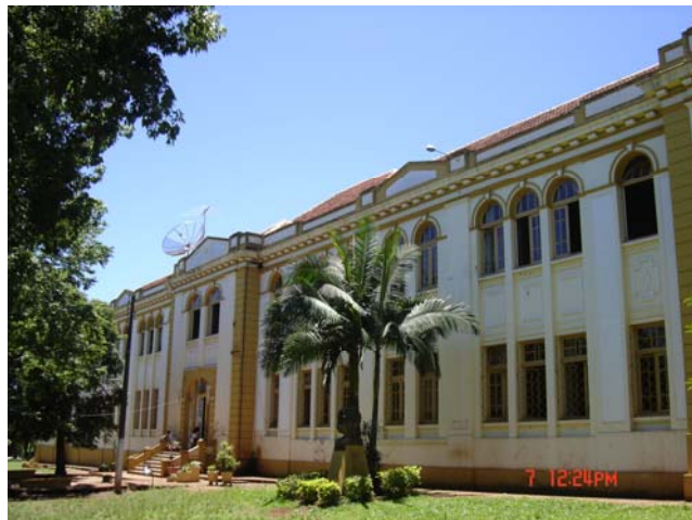
Figura 11 – Vista frontal da edificação
