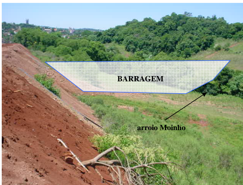
Figura 20 -Local da barragem de contenção proximidades da Rua 25 de Julho
