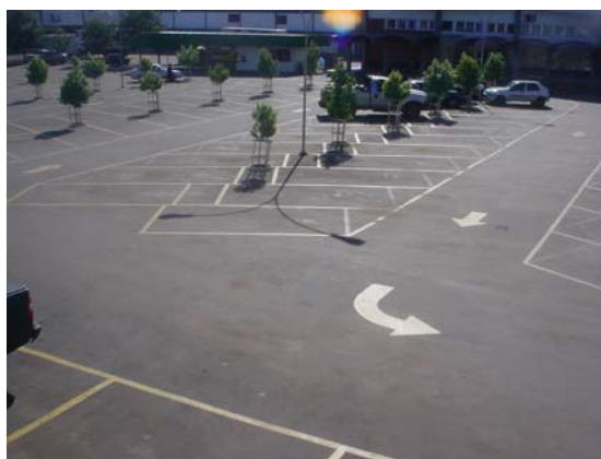
Figura 2: Impermeabilização do solo Local: Estacionamento Cotripal
