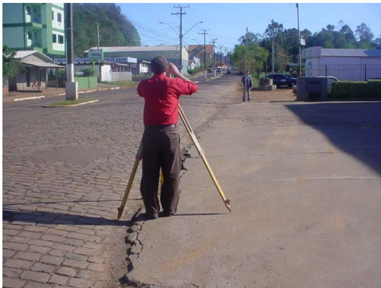
Figura 13: Levantamento topográfico Local: Av. Konrad Adenauer – Bairro Erica
