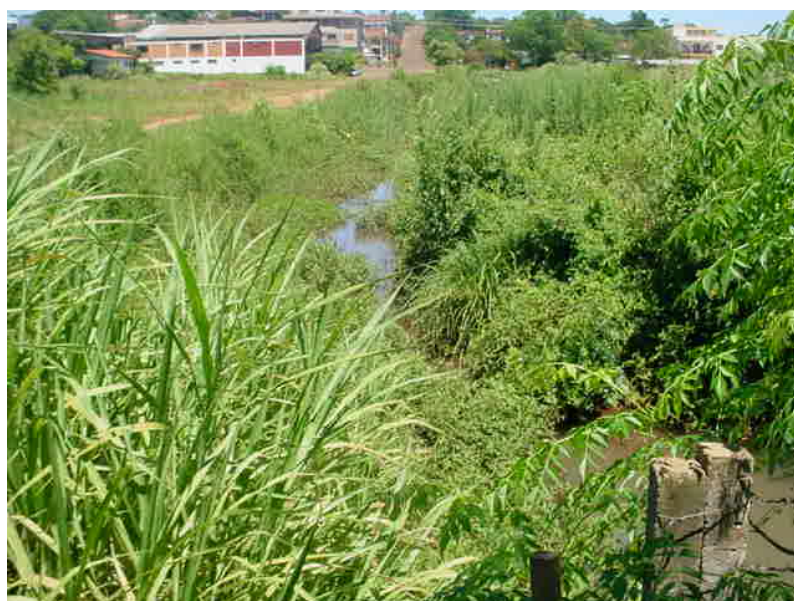
Figura 23 - Assoreamento do arroio Alagoas
