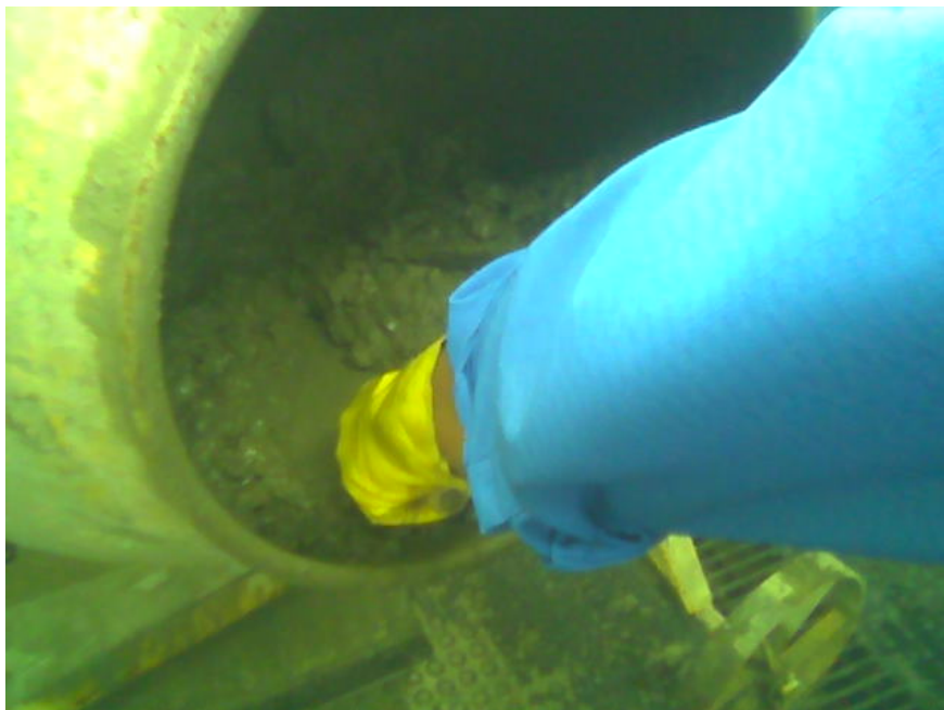
Figura 4 – Aspecto da superfície do concreto
