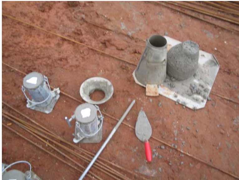
Figura 7 – Medição da consistência do concreto
