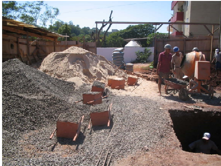
Figura 8 – Disposição dos materiais constituintes para a mistura da obra 2
