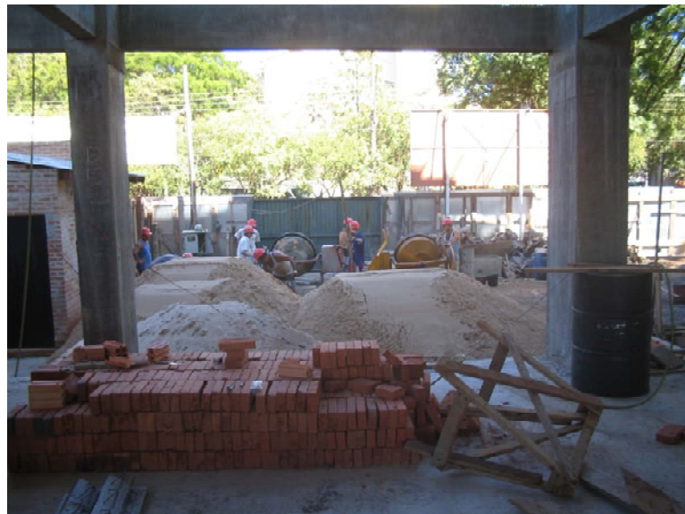
Figura 6 – Disposição dos materiais constituintes para a mistura da obra 1, com a utilização de duas betoneiras
