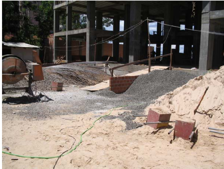
Figura 5 – Disposição dos materiais constituintes para a mistura da obra 1
