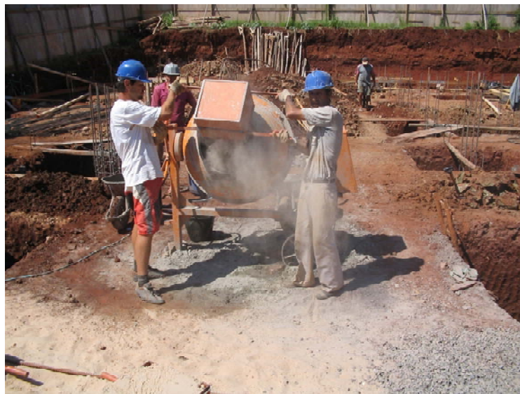
Figura 9 – Utilização de caixas metálicas para a dosagem correta
