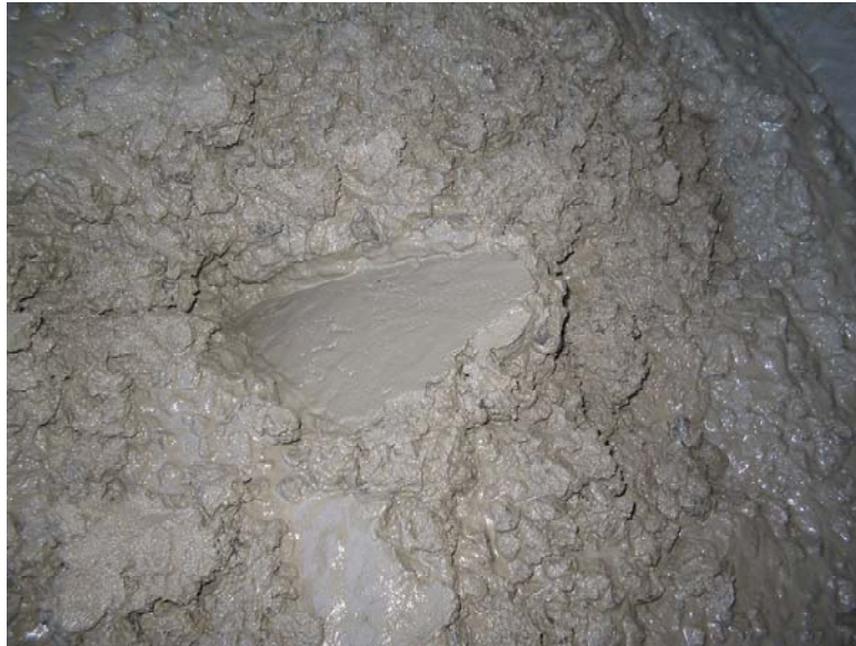
Figura 10 – Análise da consistência do concreto para aceitação
