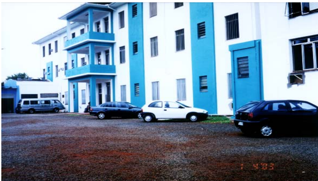
Figura 3 - Local onde está sendo executadas a reforma e ampliação de Bloco Anexo ao Cacon.
