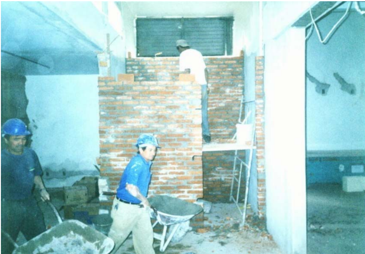
Figura 7 - Fase de execução de paredes em alvenaria de tijolo maciço.
