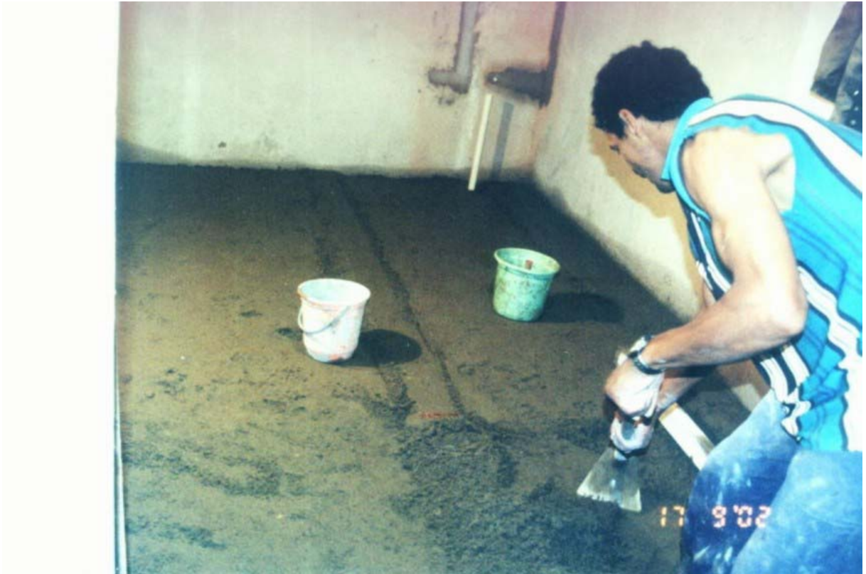
Figura 9 - Fase de execução de nivelamento do piso.
