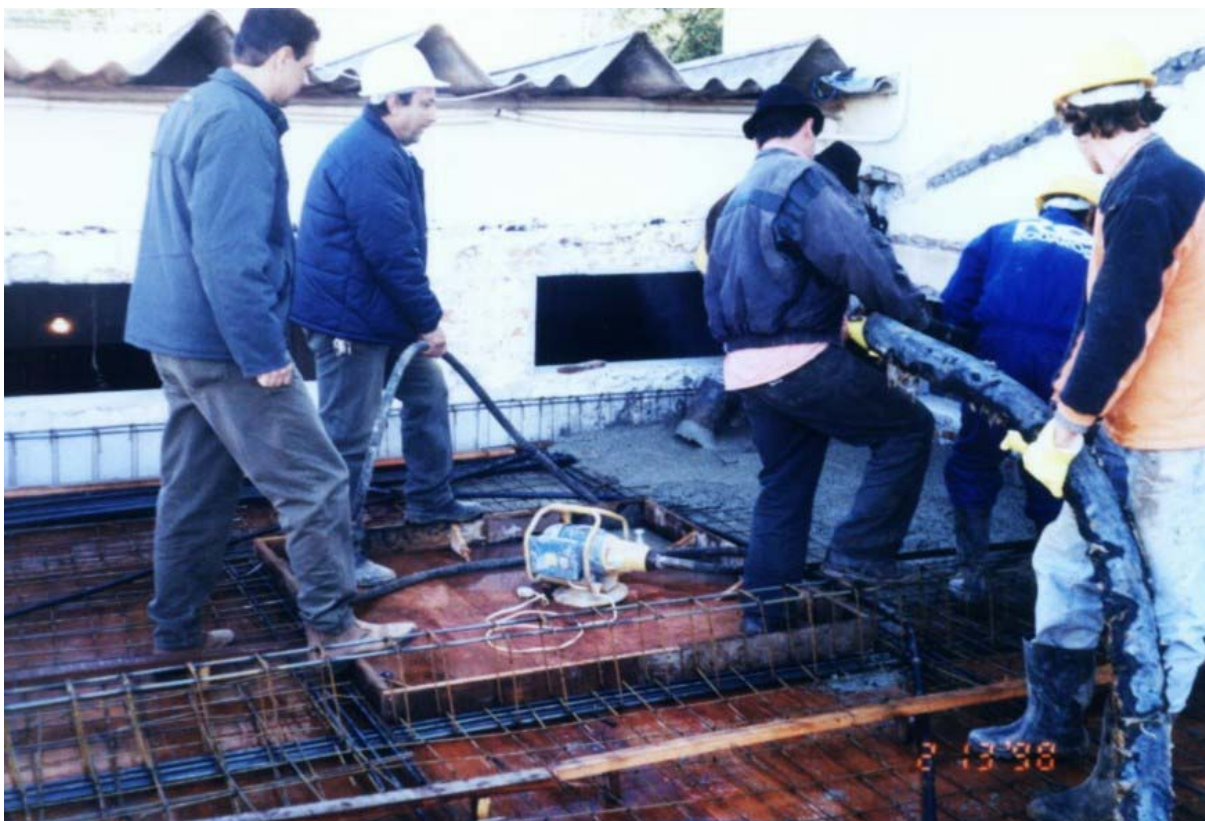
Figura 8 - Fase de execução da estrutura de ampliação do prédio.
