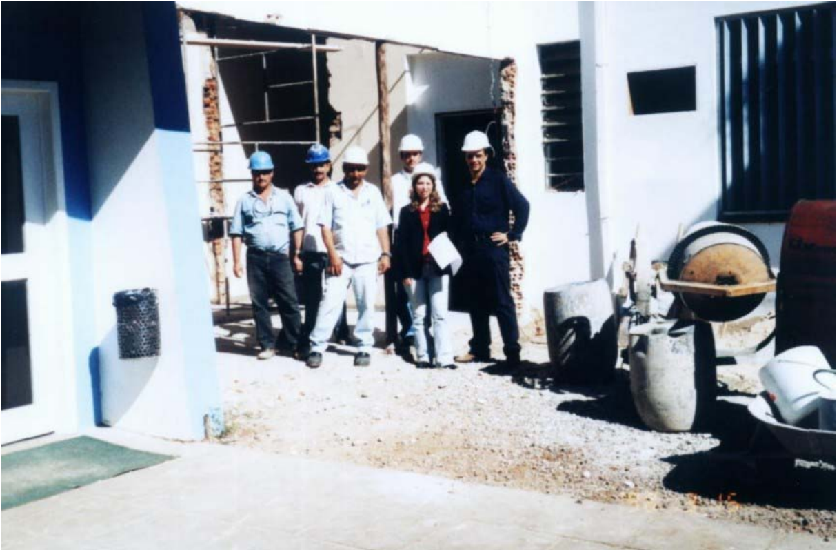
Figura 6 - Fase de demolições das paredes.
