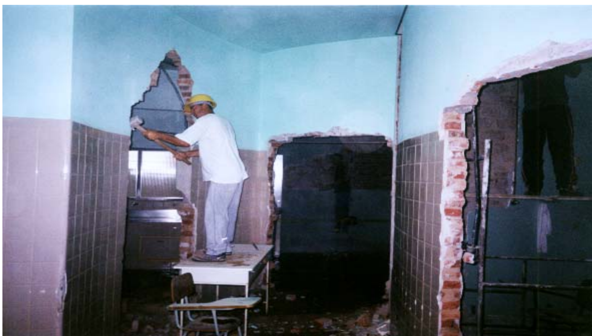
Figura 5 - Fase de demolições das paredes.
