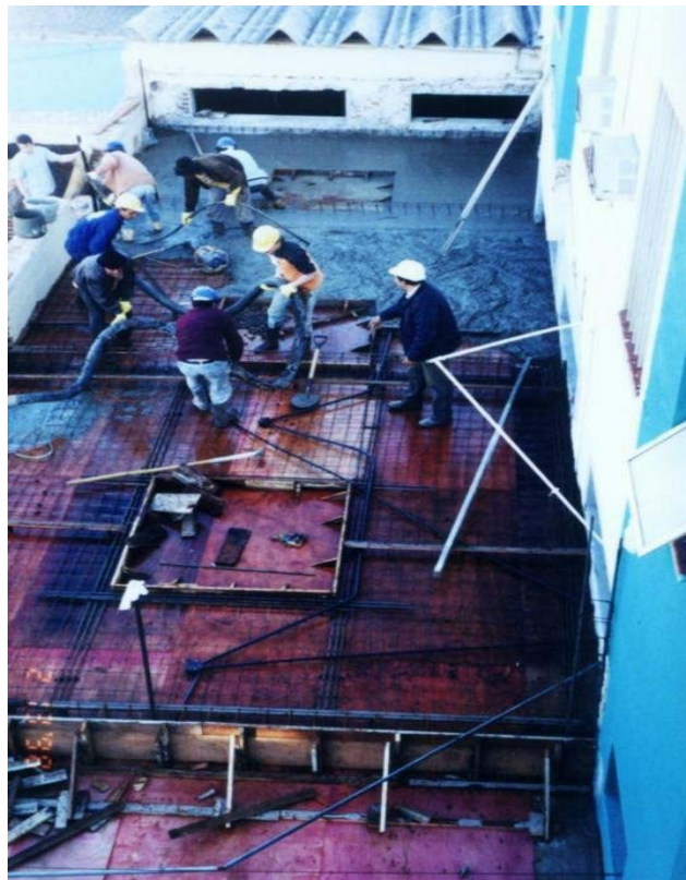
Figura 10 - Aplicação de concreto usinado para laje e viga armada.
