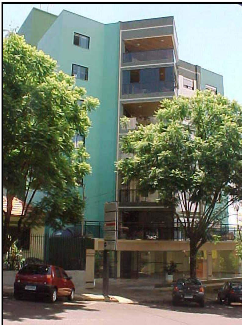
Figura 7 – Fachada leste – Edifício Aquarius.
