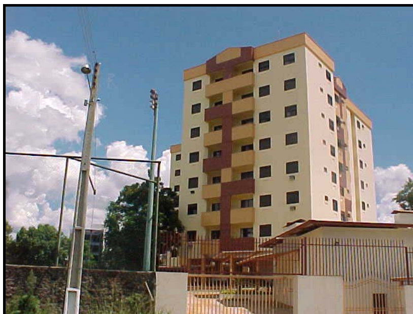
Figura 14 – Fachada nordeste – Partenon
