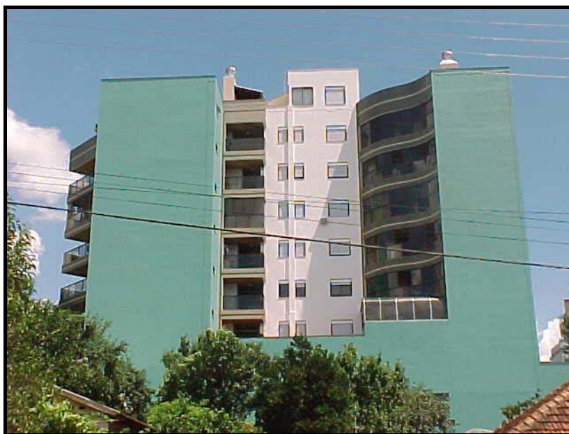
Figura 9 – Fachada norte – Edifício Aquarius.
