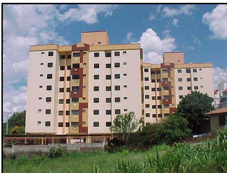
Figura 13 – Fachada noroeste – Residencial Partenon.
