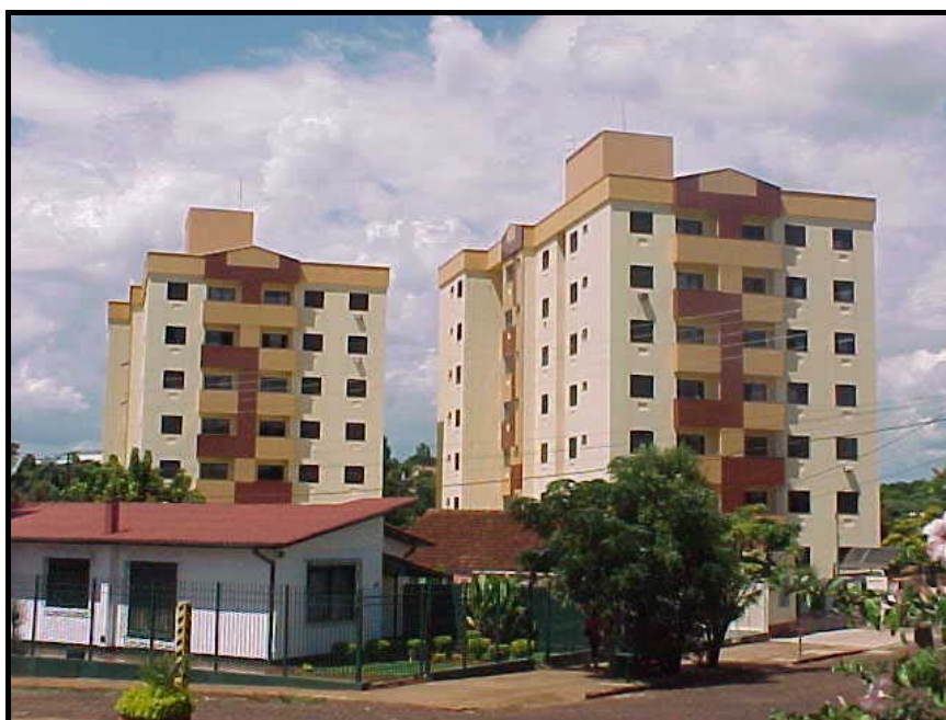
Figura 11 – Fachada sudoeste – Residencial Partenon.
