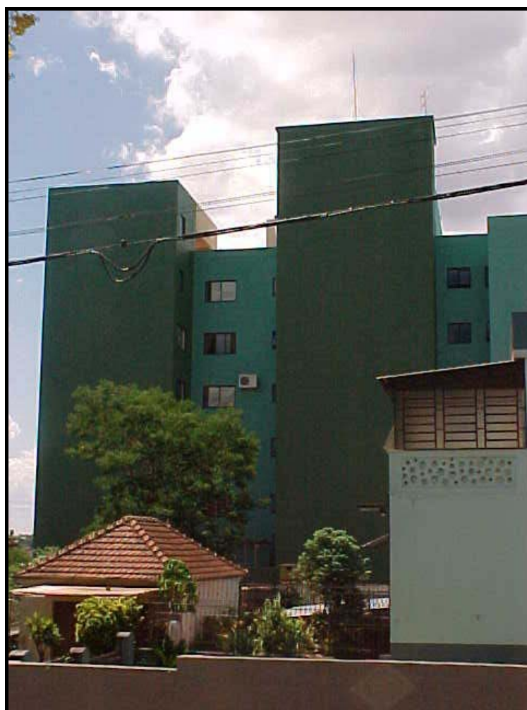
Figura 6 – Fachada sul – Edifício Aquarius.
