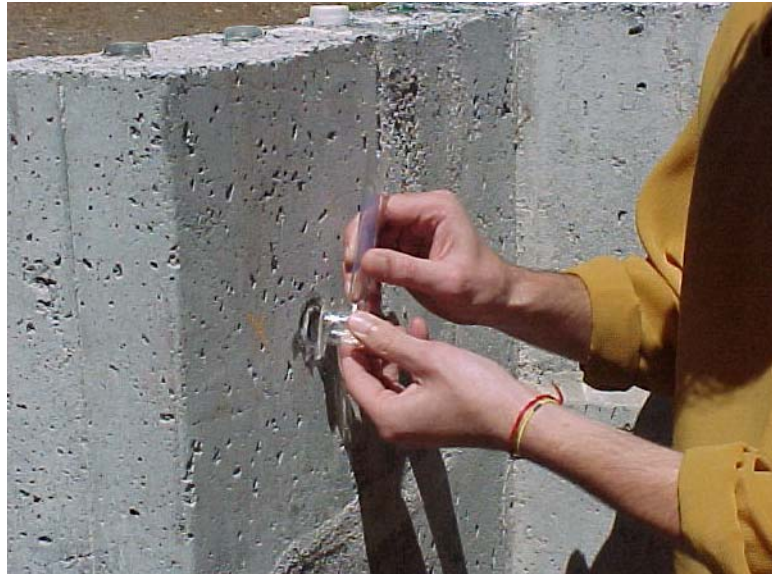
FIGURA 14 – Detalhe da fixação do “cachimbo” na parede
