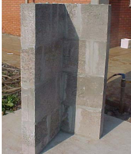
FIGURA 9 – Parede em teste às intempéries
