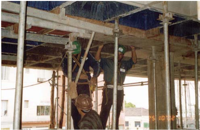
Figura 5: Sistema de segurança EPIs , obra 1
