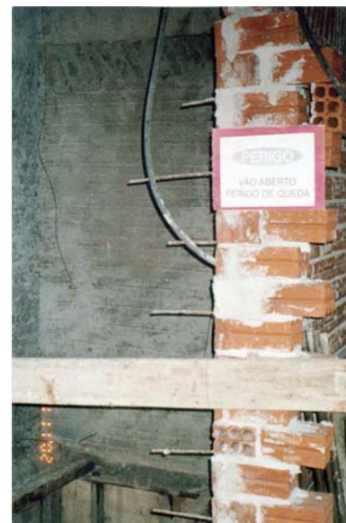
Figura 9: Proteção e placa de indicação na obra 2
