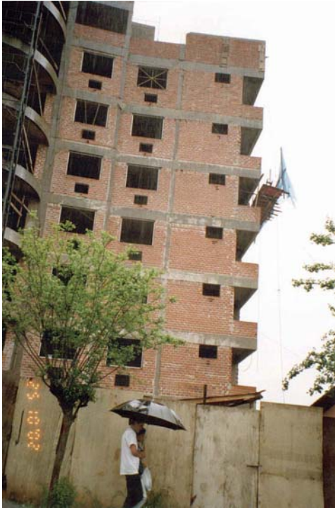
Figura 11: Vista parcial e andaime suspenso da obra 2
