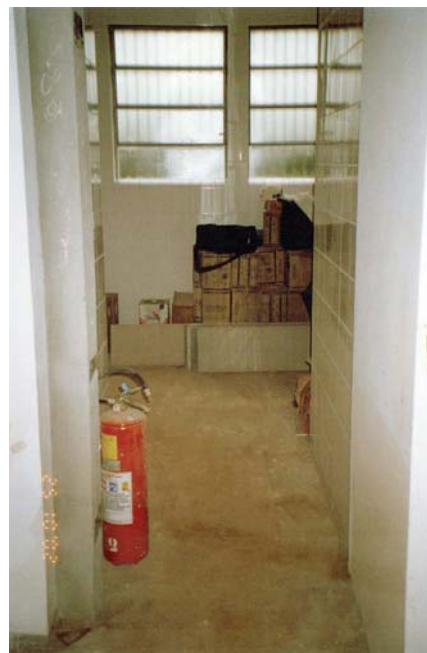
Figura 15: Local do extintor móvel de incêndio na obra 3
