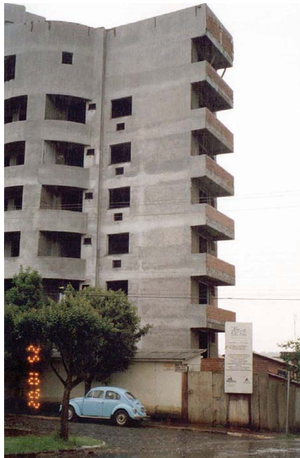
Figura 7: Vista parcial da obra 2
