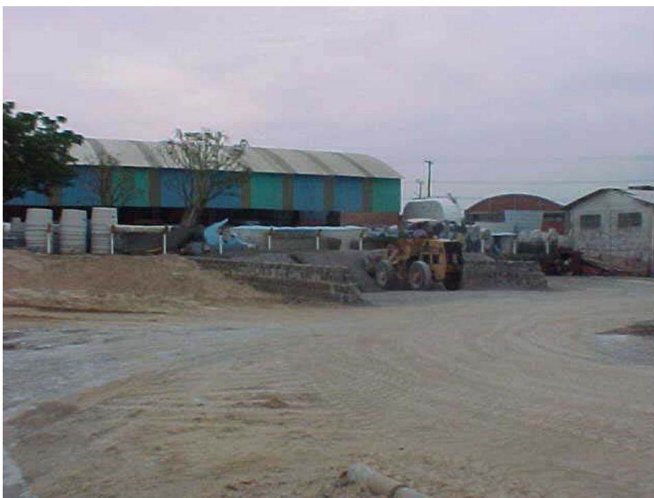
Figura 37 – Armazenamento dos agregados – Prontomix – Santa Maria
