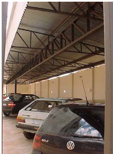
Figura 16: Vista parcial da pavimentação dos recuos, utilizados com estacionamento
