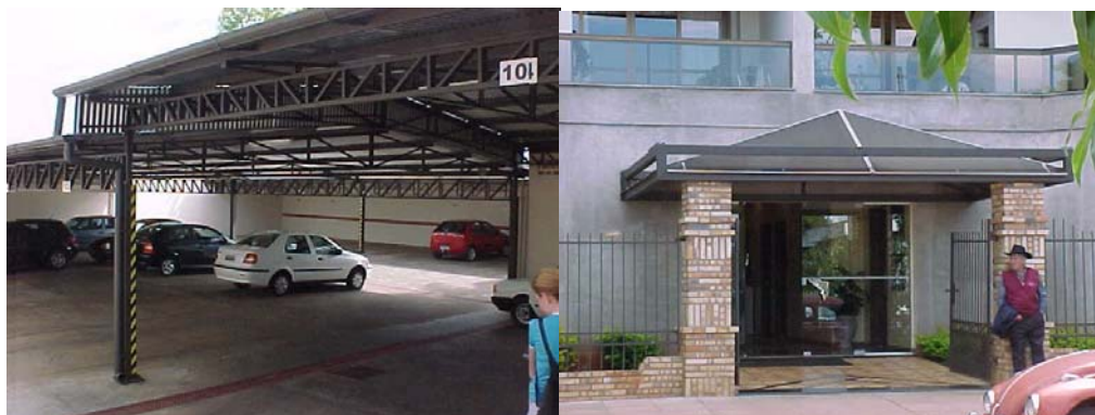
Figura 3: Vistas parciais do estacionamento coberto e da entrada da Clínica Médica
