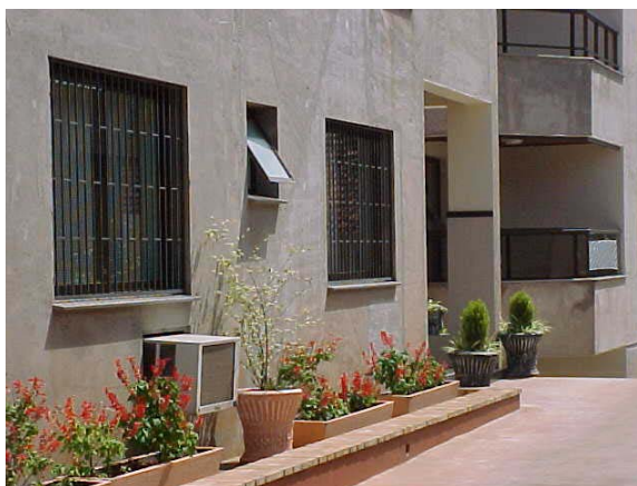
Figura 6: Vista parcial das janelas dos consultórios – excesso de iluminação
