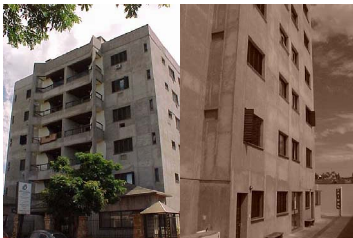
Figura 2: Vistas parciais da fachada principal e de fundos do edifício Garoupa
