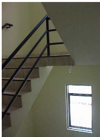
Figura 8: Vista da janela basculante da escada enclausurada da edificação
