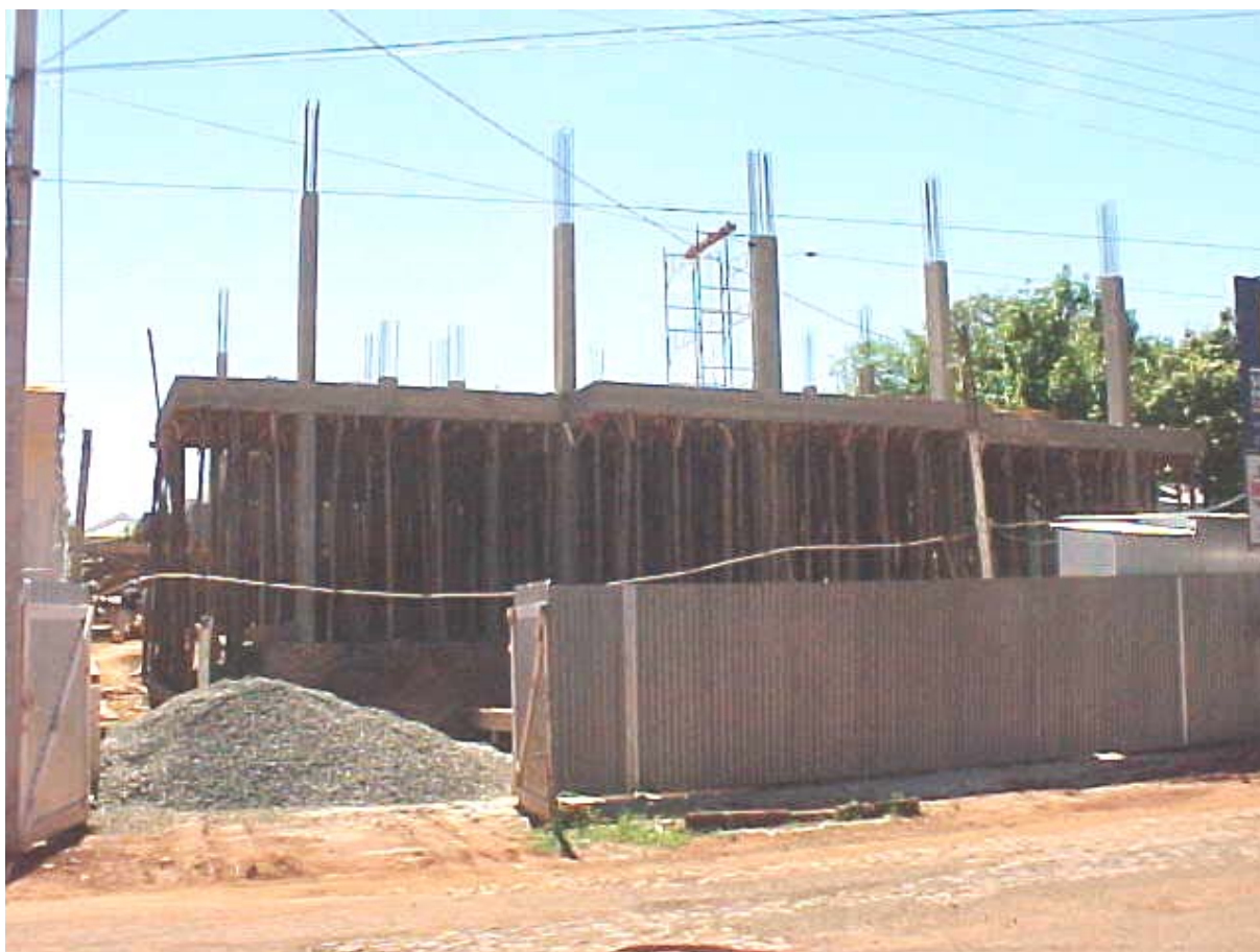
Figura 5 - Fachada principal da obra E
