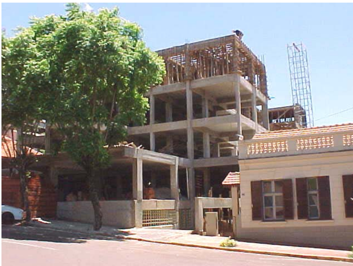
Figura 4 - Fachada principal da obra D
