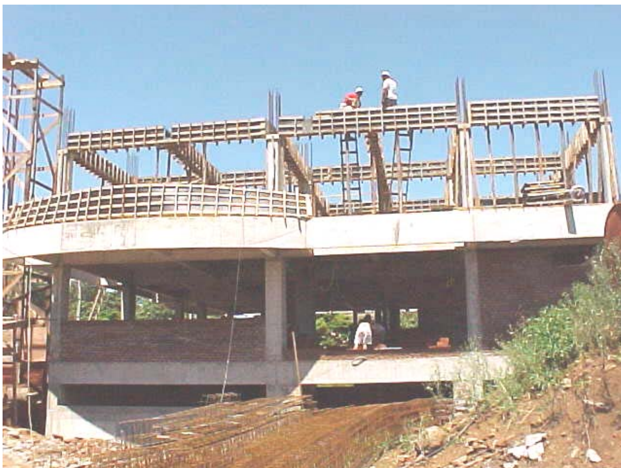
Figura 2 - Fachada lateral da obra B
