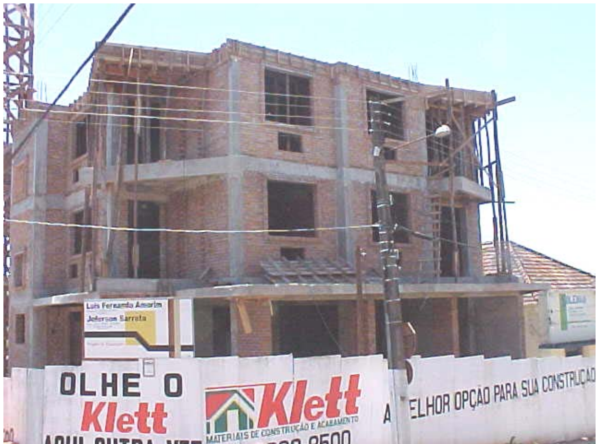
Figura 6 - Fachada principal da obra F
