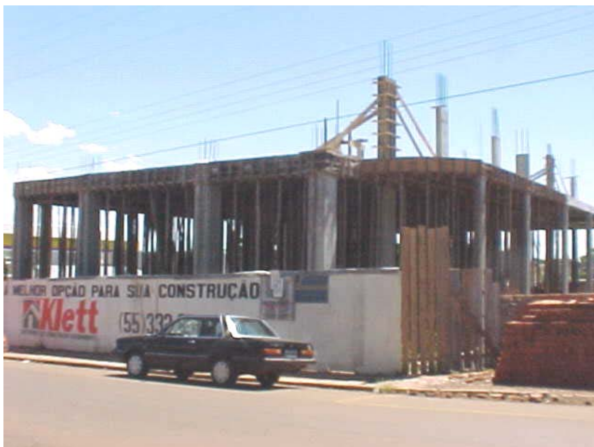
Figura 3 –Fachada principal da obra C
