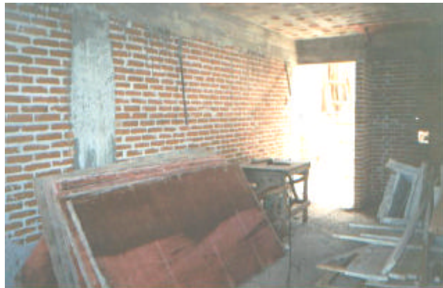
Figura 7 – Armazenamento de chapas de compensado para laje
