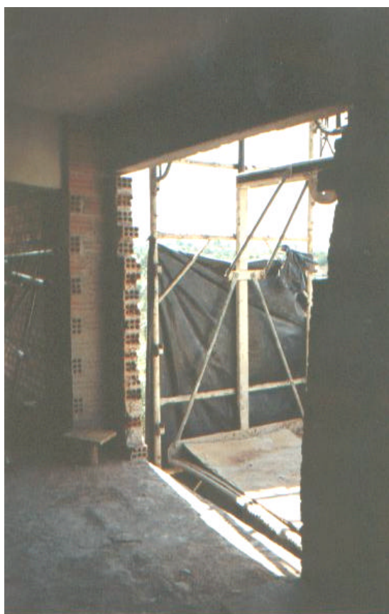
Figura 32 – Abertura na alvenaria feita para utilização do transporte vertical
