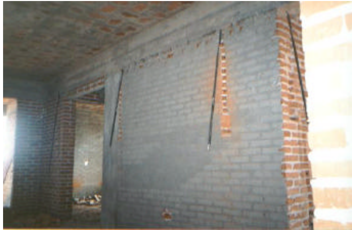
Figura 14 – Cortes na alvenaria para passagem de eletrodutos
