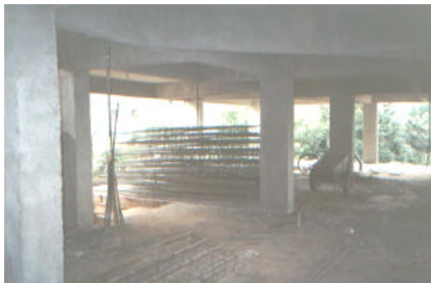
Figura 22 – Depósito de armadura para vigas
