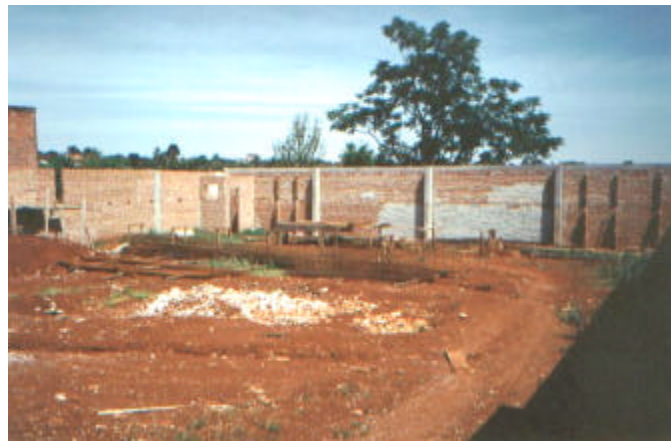
Figura 4 – Vista parcial dos fundos do canteiro
