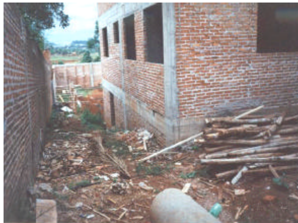
Figura 13 – Entulho gerado pela desforma de vigas e pilares
