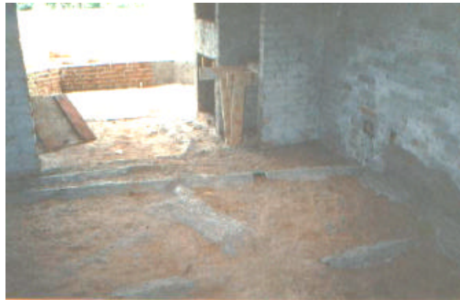
Figura 11 – Colocação dos eletrodutos após a concretagem da laje
