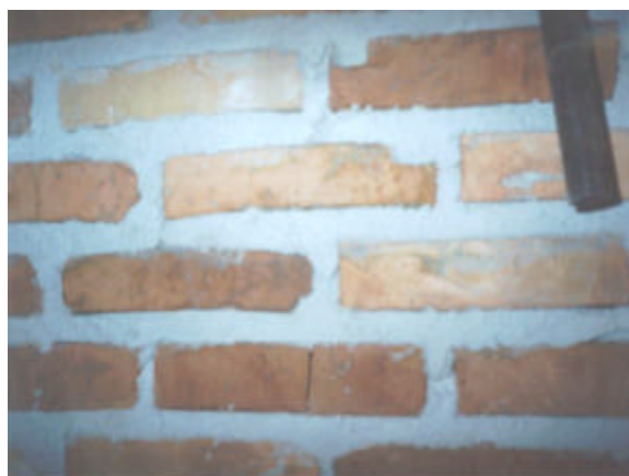
Figura 17 – Vista da situação das juntas de argamassa
