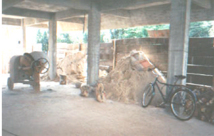
Figura 12 – Vista da central de argamassa
