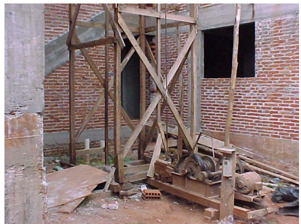
Figura 4.1.2.1 – Detalhe de funcionário executando a alvenaria. Figura 4.1.2.2 – Detalhe do elevador da obra.
