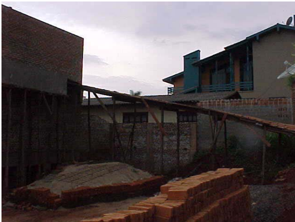
Figura 4.3.2.1 – Rampa utilizada para transporte vertical.
