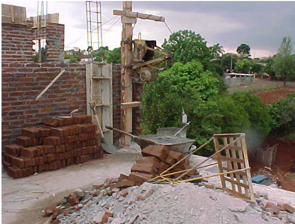
Figura 4.2.2.1 – Detalhe do guincho de obra, Figura 4.2.2.2 – Funcionário executando depósito de entulho, transporte de alvenaria externa, próximo a local sem argamassa e disposição dos tijolos no proteção. pavimento.
