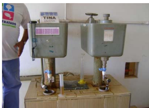
Figura 2- Dosagem do Sulfato de Alumínio
