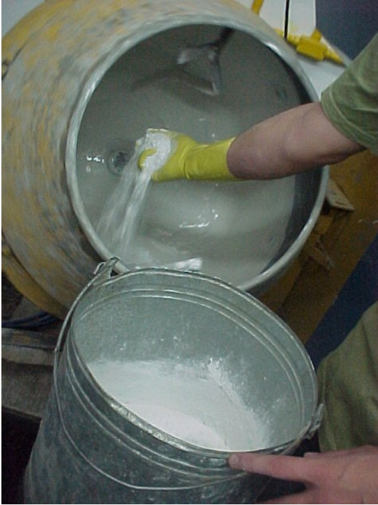
Figura 4 - Colocação da Cal na betoneira
